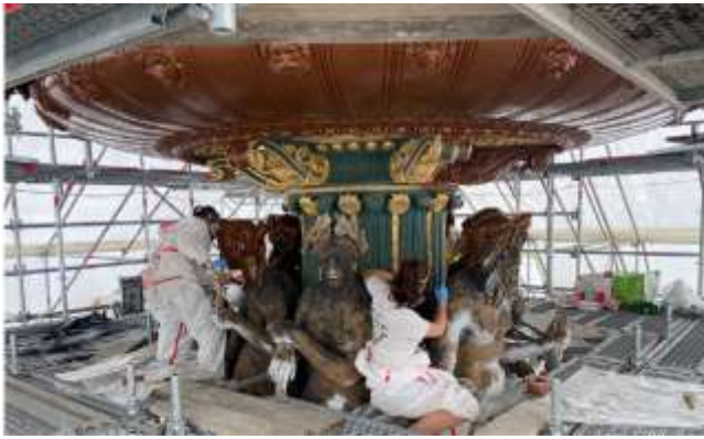
Fontaines en cours de rénovation, été 2023
