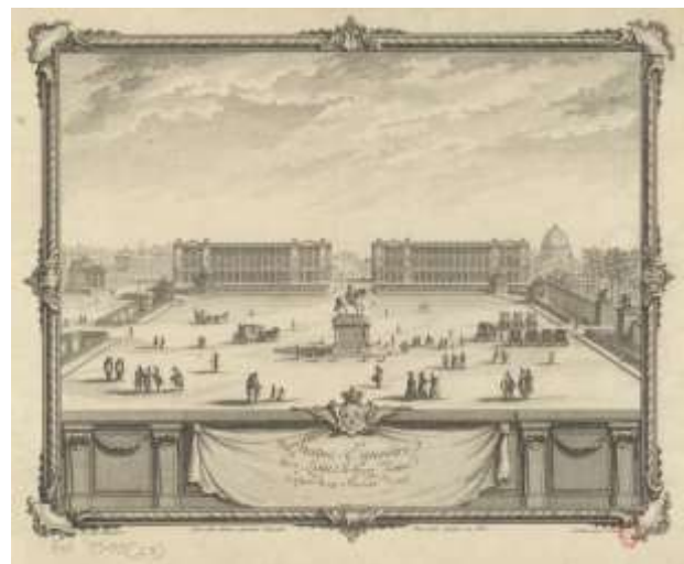
Vue de la place achevée : fossés, trottoirs périphériques, sol en terre, 1763
