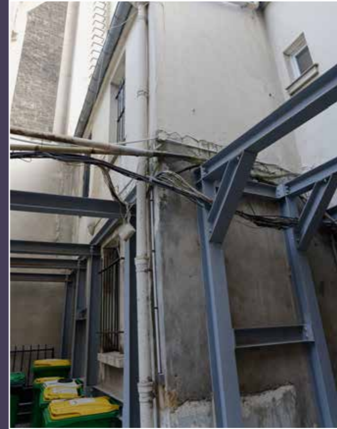
Vue du confortement des façades sur cour (© Projedia).
