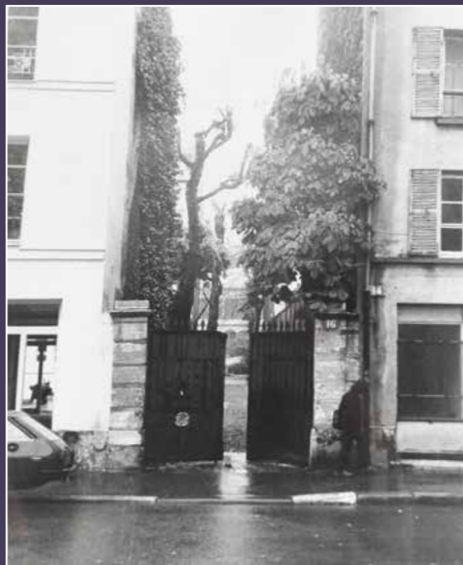
Vue de l'entrée vers 1980 (CVP).
