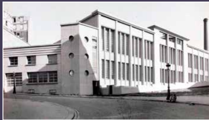
Photographie Industrielle Nobécourt, façade du nouveau bâtiment sur la rue des Reculettes, [1939-1942] (Musée Carnavalet).
