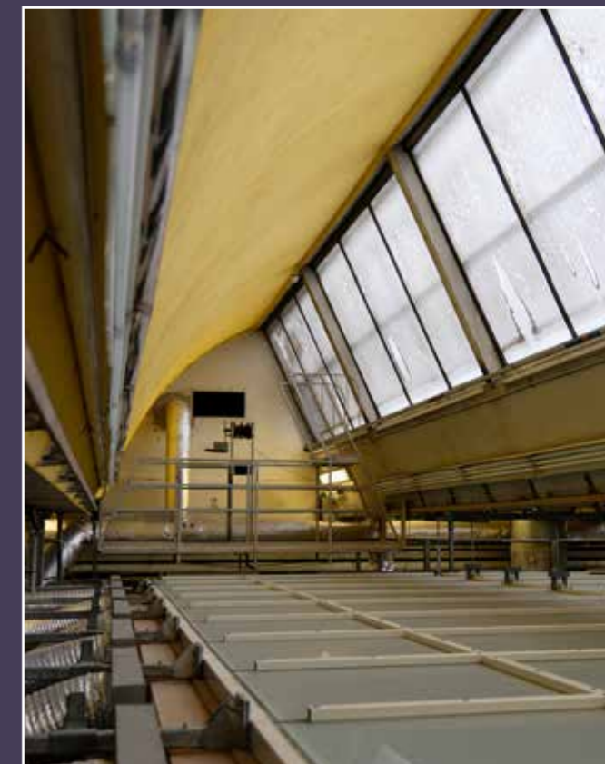
Vue de l'intérieur des sheds en toiture, 2024 (© DHAAP / PS).
