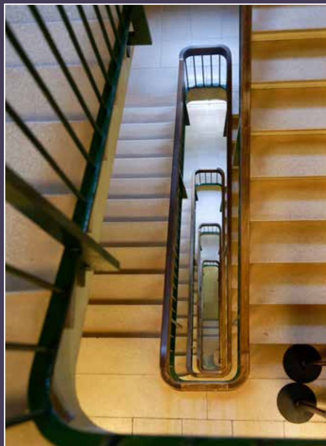
Vue de l'un des escaliers en béton, 2024 (© DHAAP / PS).
