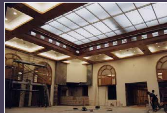
Vue du restaurant pendant les travaux, 20 septembre 1999 (Archives de la Banque de France).
