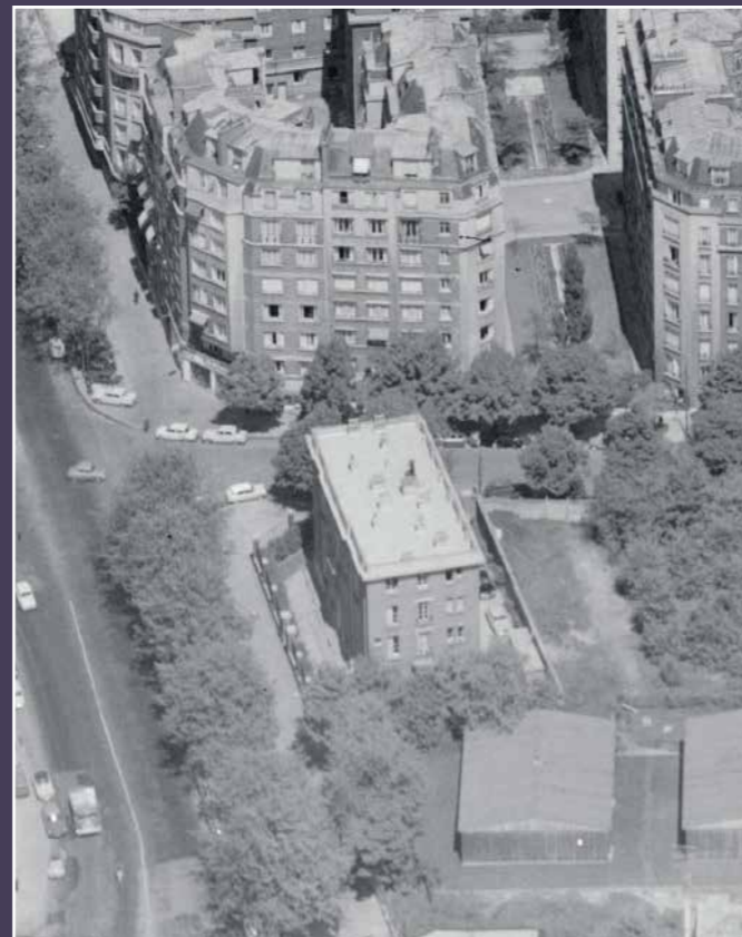
Vue aérienne montrant le bureau et deux bâtiments provisoires de construction légère, 1964 (© IGN).
