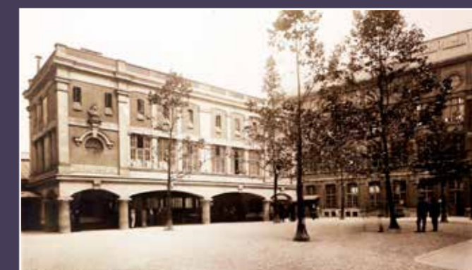
Anonyme, École du livre Estienne, nouveau pavillon de la photographie (Glaize architecte), après 1908 (AD75).
