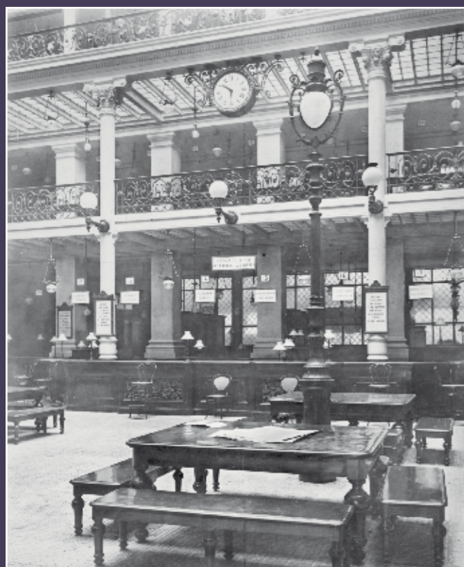
Vue intérieure à la fin du chantier (vue du hall), [vers 1893] (Archives de la Banque de France).
