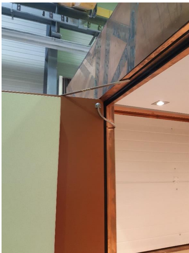
Photo de porte d'accès montrant la butée haute
