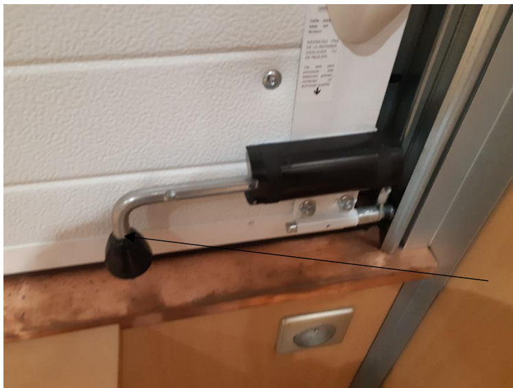
Verrouillage en partie intérieure
