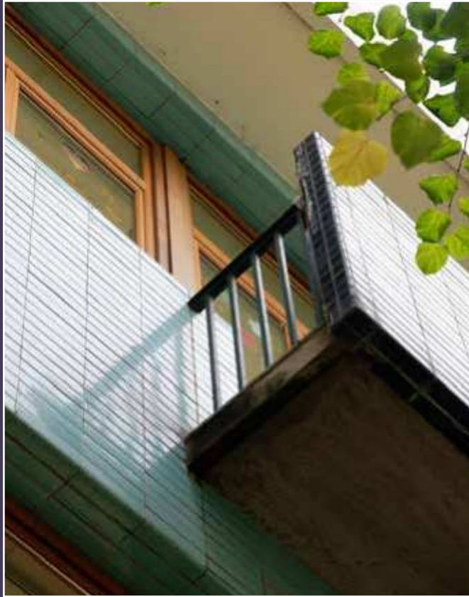
Détails de la façade du bâtiment Ravier, 2024 (© DHAAP / ML).
