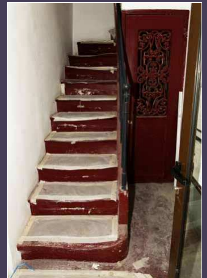
Vue de l'escalier avec limon à la française qui dessert encore les étages entre les deux lots concernés (© DHAAP / ML).
