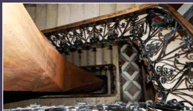
Vue de la cage d'escalier principal avec ascenseur dans le jour, 2024 (© DHAAP / ML)
