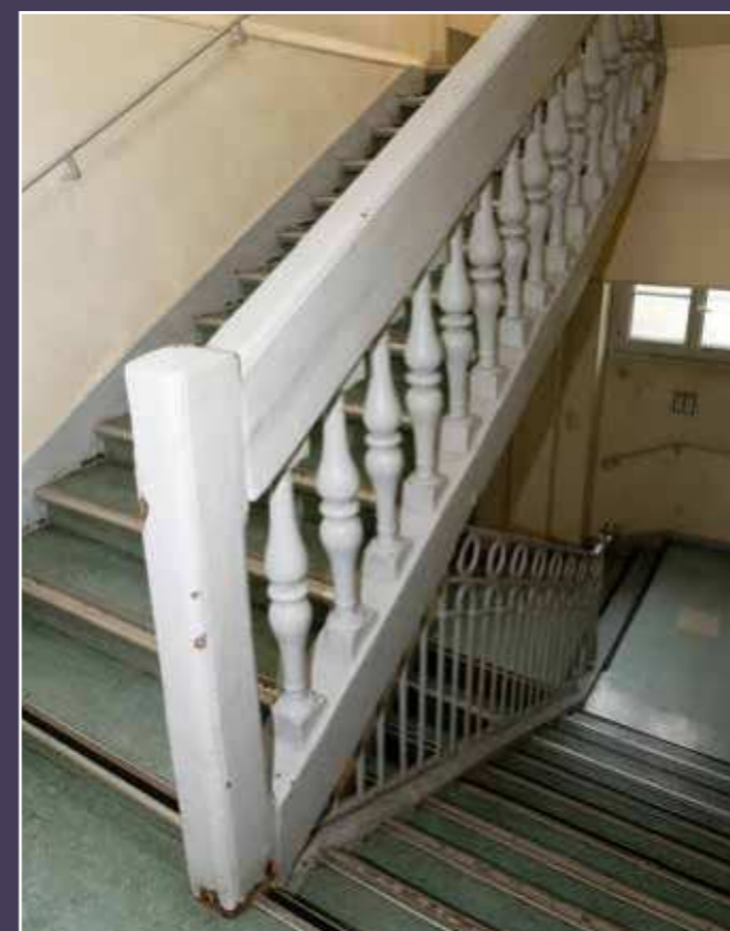
Vue de l'escalier du 7 rue des Minimes, 2022 (© DHAAP / ML).
