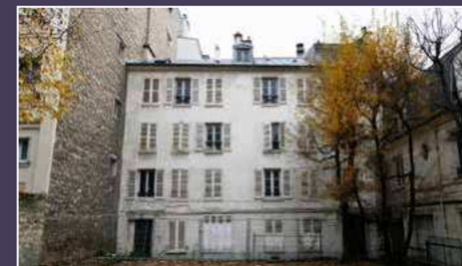
Vue du bâtiment avec accès par le 68, rue de la Tour, nommé D, donnant sur l'espace vert protégé, 2024 (© DHAAP / ML).
