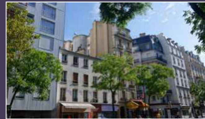
Vue sur rue. À gauche, l'opération des années 1960. À droite, l'immeuble édifié dans les années 1890 pour l'ouverture de la rue Gonnot, 2024 (© DHAAP / PS).
