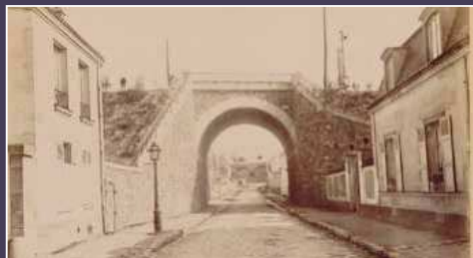
Vue du viaduc de la Petite Ceinture publiée par Albert Broise, Syndicat du chemin de fer de ceinture de Paris. Suppression des passages à niveau, 1887-1889 (© BnF / Gallica).
