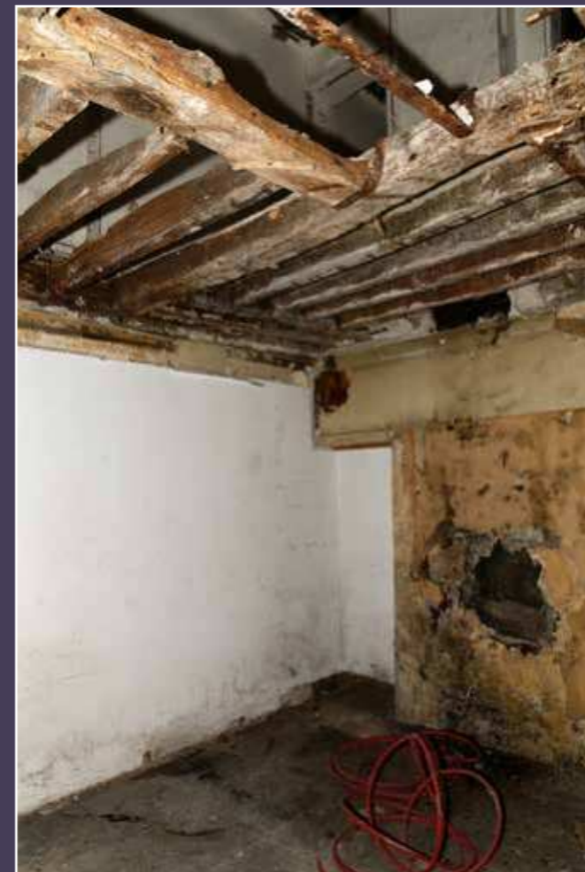
Vue du plafond plancher des lots concernés (© DHAAP / ML).
