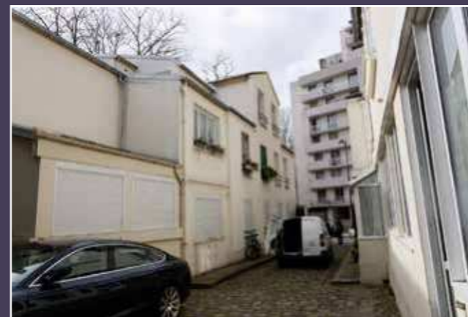
Vue depuis la cour du bâtiment partiellement réhaussé, 2024 (© DHAAP / PS).
