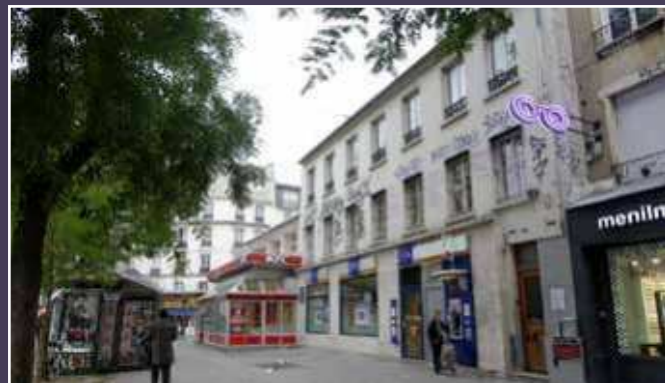
Vue de l'immeuble, sis au 150 boulevard de Ménilmontant dont la surélévation est demandée, 2014 (© DHAAP / PS).
