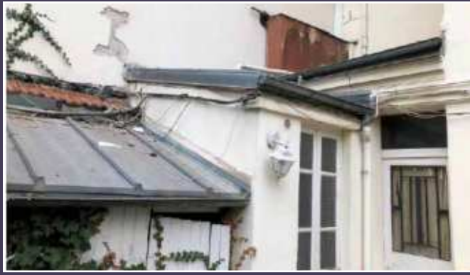
Vue de l'appentis contre le mitoyen du n° 50, 2022 (© 3F).
