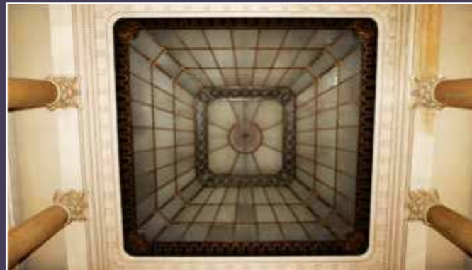
Vue de la verrière au-dessus de l'escalier monumental, 2024 (© DHAAP / ML).
