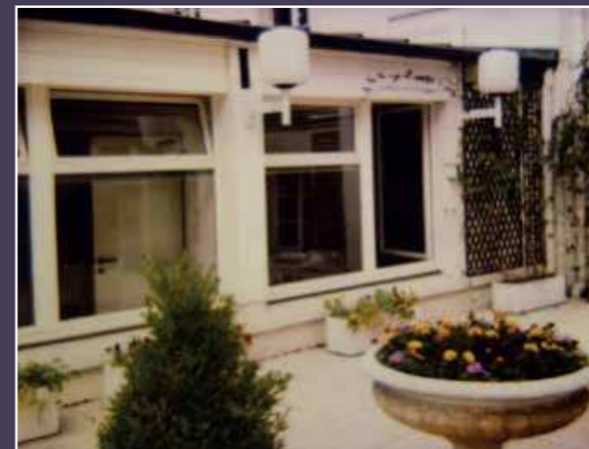
Vue de la surélévation côté cour, 1993 (AD75).
