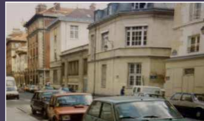
Élévation sur la rue de Béarn avant surélévation, 1993 (AD75).
