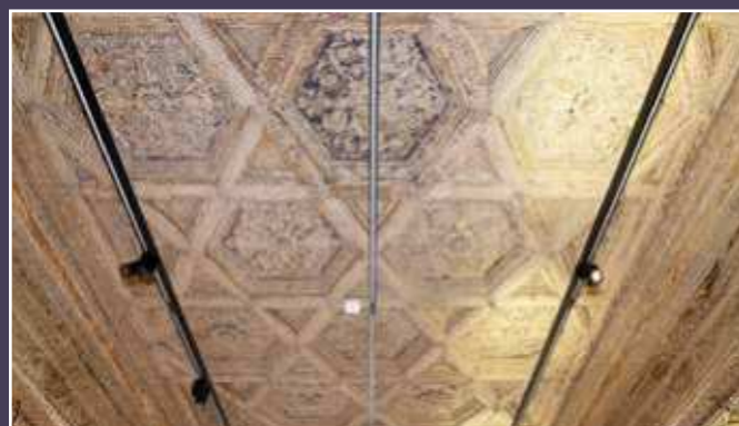
Vue du plafond à cassons au deuxième étage, 2024 (© DHAAP / ML)
