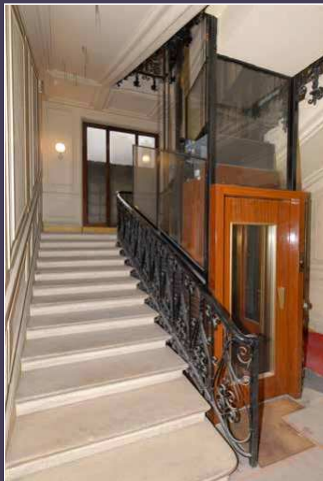
Vue de l'escalier principal avec ascenseur, 2010 (© DHAAP / ML)
