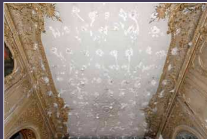
Vue du plafond décoré suite à la dépose d'un faux-plafond, 2010 (© DHAAP / ML)
