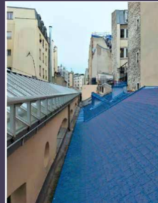
Vue des toitures dont la démolition est demandée (© AHA!).
