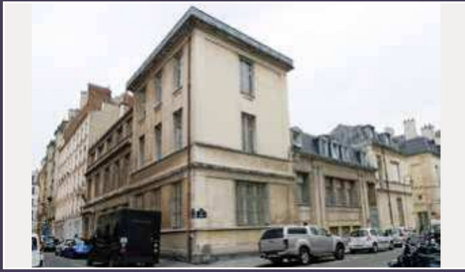
Vue depuis l'angle rue des Minimes et rue de Béarn, 2022 (© DHAAP / ML).
