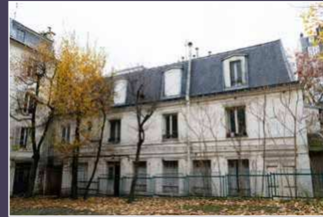
Vue du bâtiment avec accès par le 68, rue de la Tour, nommé E, en retour d'équerre avec le bâtiment indiqué par D, 2024 (© DHAAP / ML).
