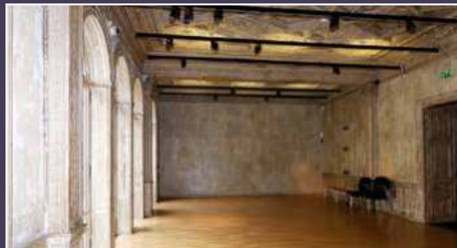
Vue des salons donnant du deuxième étage sur la rue Volney, réunis lors de la dernière campagne de travaux, 2024 (© DHAAP / ML)
