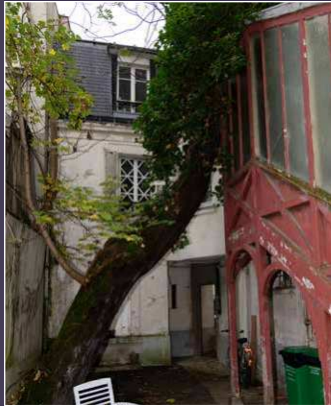
Vue de la petite cour ayant accès par le 68, rue de la Tour ; l'escalier en bois avec structure couverte serait démoli, 2024 (© DHAAP / ML).
