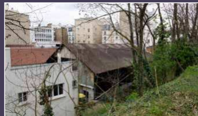
Vue du hangar depuis la Petite Ceinture, 2024 (© DHAAP / PS).
