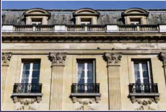
Vue de détail des pilastres corinthiens colossaux de la façade donnant sur l'avenue Foch de l'hôtel, 2024 (© DHAAP / ML).
