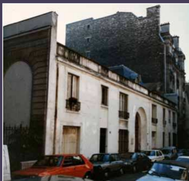
Photo du pavillon d'entrée de la parcelle au 11b-15b rue Louis David, datant de 1925, permis de démolir de 1988 (AD75).
