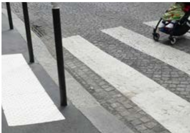
Une bande podotactile rue Henri Poincaré
