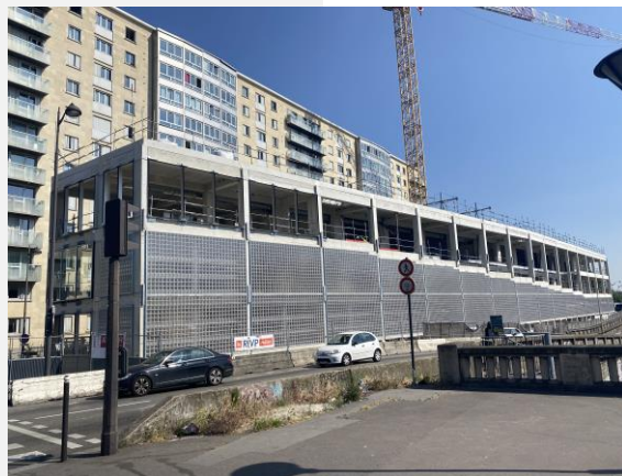
Chantier en cours
