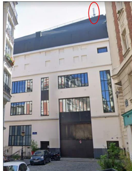
Etat projeté : Pas de modification visuelle
