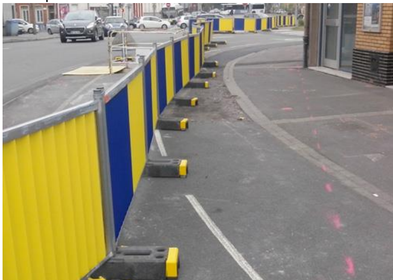
Image tirée du Guide CEREMA 2018 : Piétons et chantiers urbains
