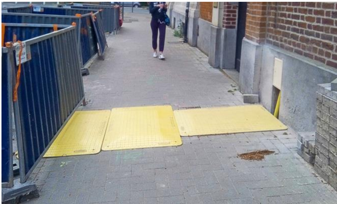
Image tirée du guide CEREMA 2018 : Piétons et chantiers urbains
