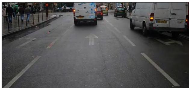
En section courante les files peuvent être matérialisées sur des voies à fort débit ( $\geq 500$  véhicules / h / par file) et dans le cas de files étroites, pour optimiser la capacité de la voie.
