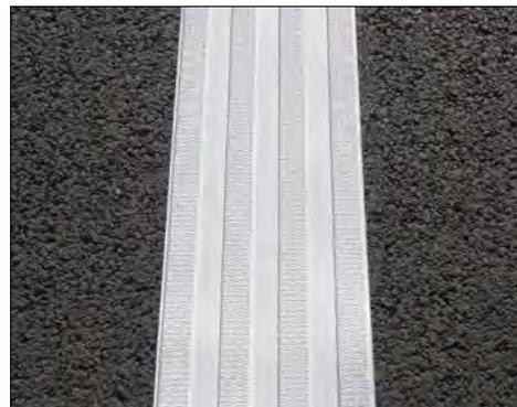
Il était d'usage sur Paris de recourir à ce type de bande nervurée, avant qu'elles ne fassent l'objet d'une normalisation, pour séparer l'espace affecté aux piétons à celui affecté à d'autres usages. Ce type d'usage n'est plus réglementaire.
