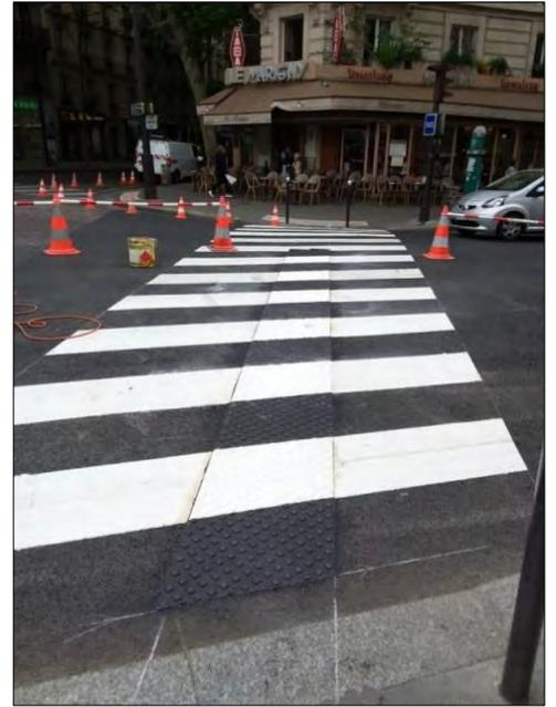
Le dispositif donnant le de plus satisfaction au niveau des associations de personnes aveugles et mal voyantes est un « tapis traversant » structuré, testé sur Paris suivant un dispositif expérimental autorisé par la DSR (Direction de la Sécurité Routière).
