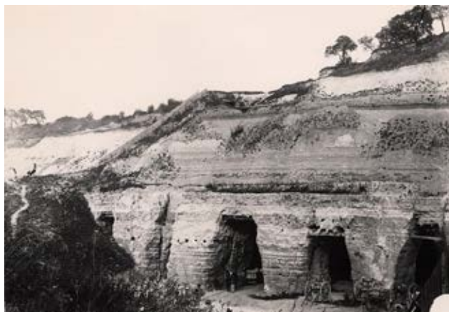
Entrées en cavage d'une carrière de gypse
