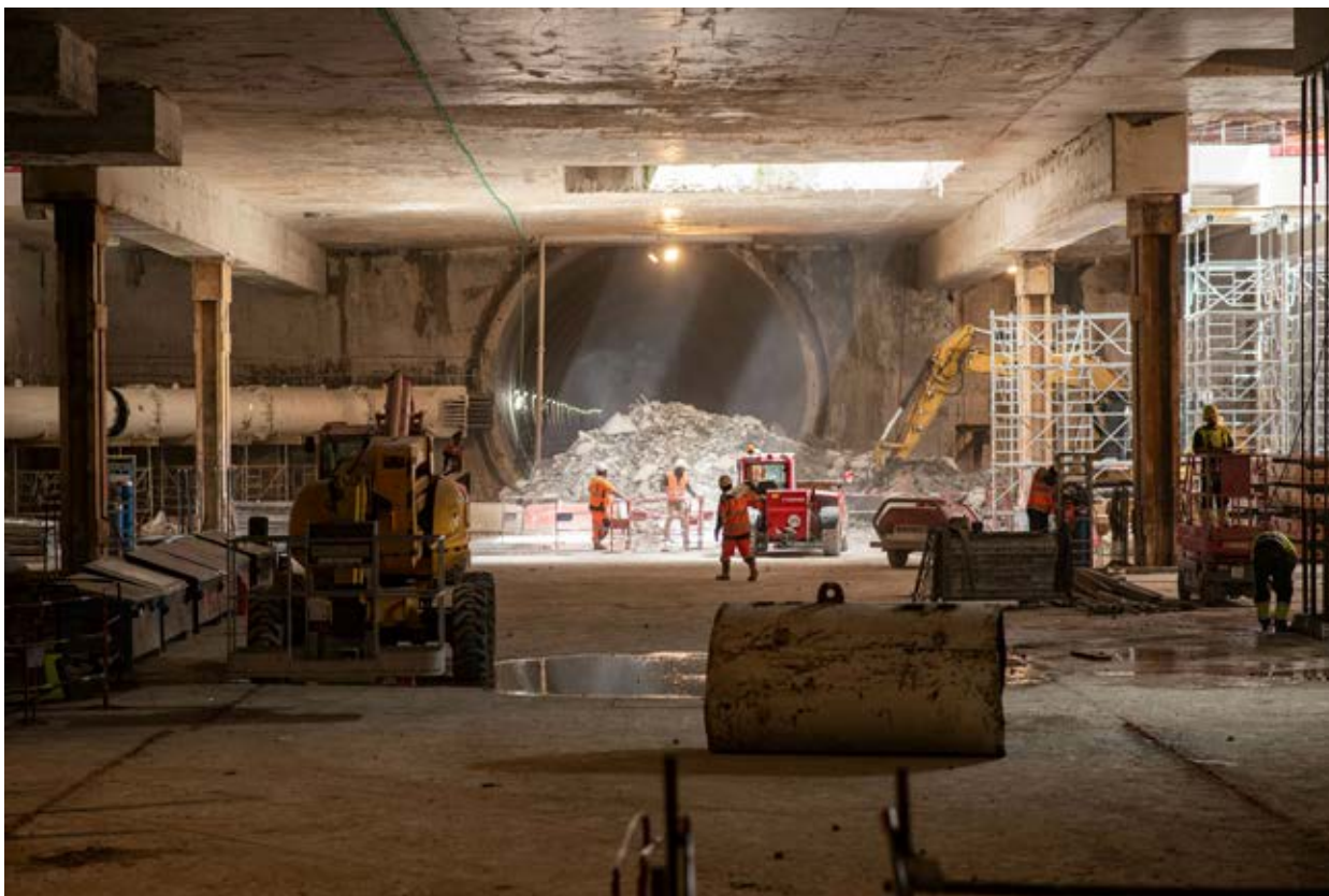
Chantier du Grand Paris Express
