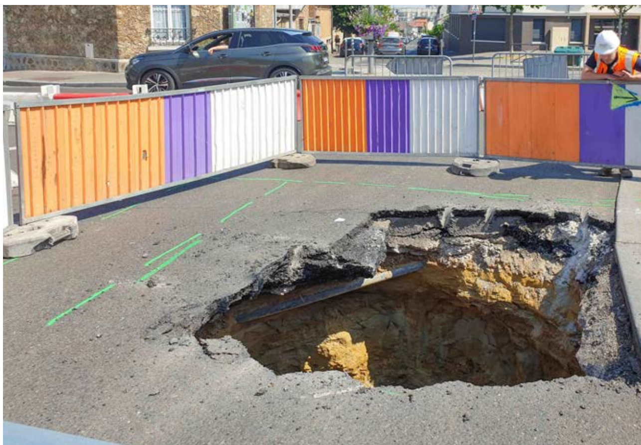
Fontis venu à jour en 2023 à Châtillon (92), au croisement de deux routes départementales
