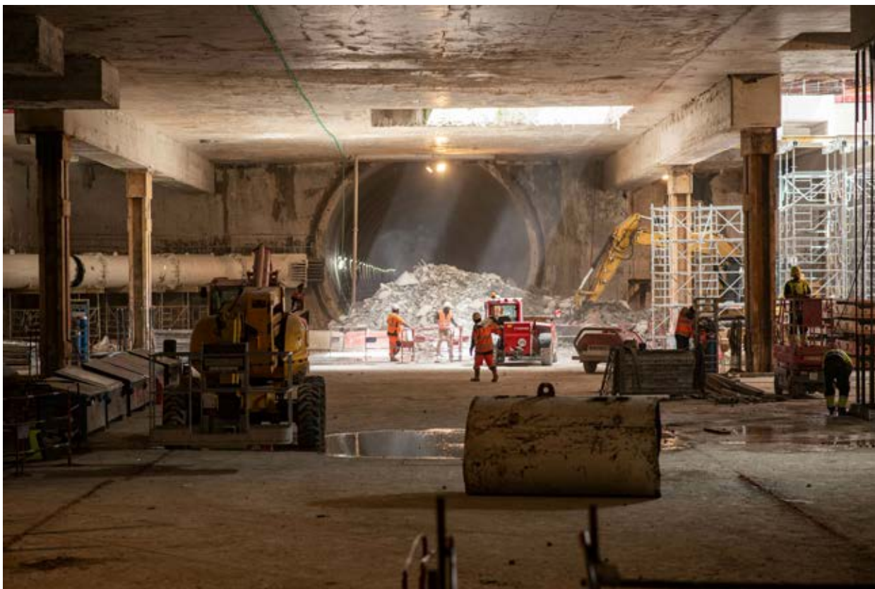
Chantier du Grand Paris Express
