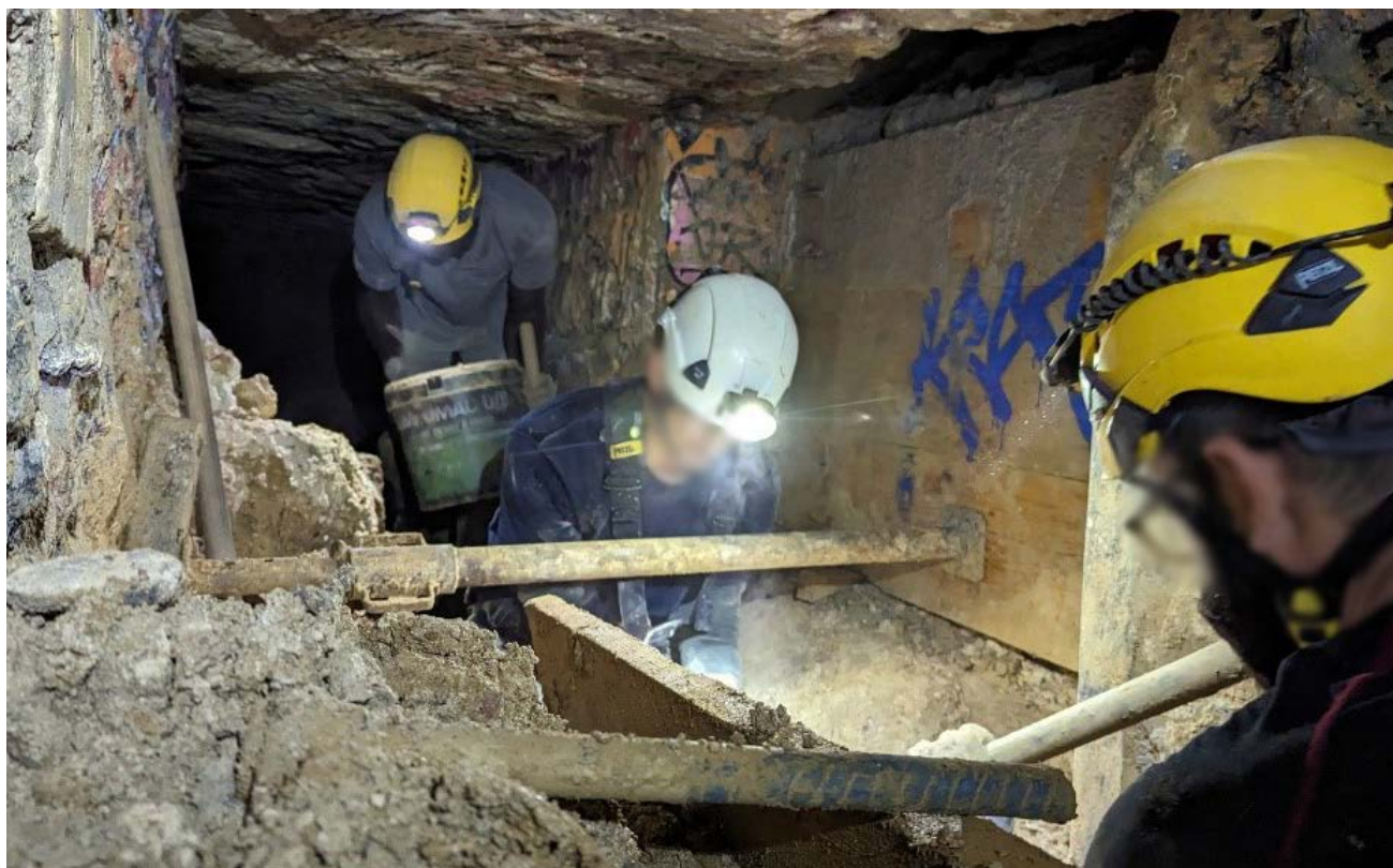
La brigade de l'IGC effectue des travaux de sécurité pour bloquer un éboulement instable
