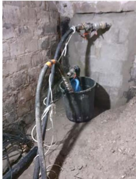
Murage de la galerie, raccordement des gaines d'injections
