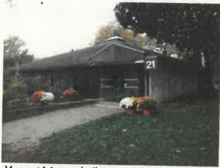
Vue extérieure de l'ouvrant de désenfumage au faitage
