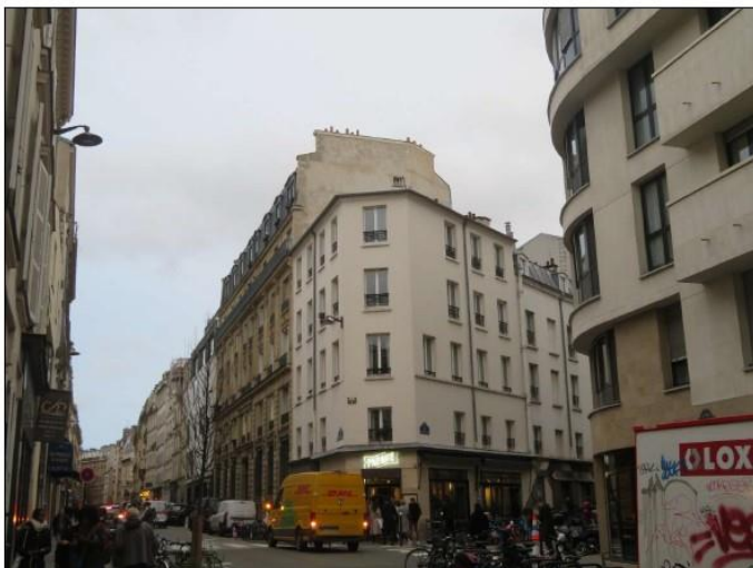
État de l'existant :
