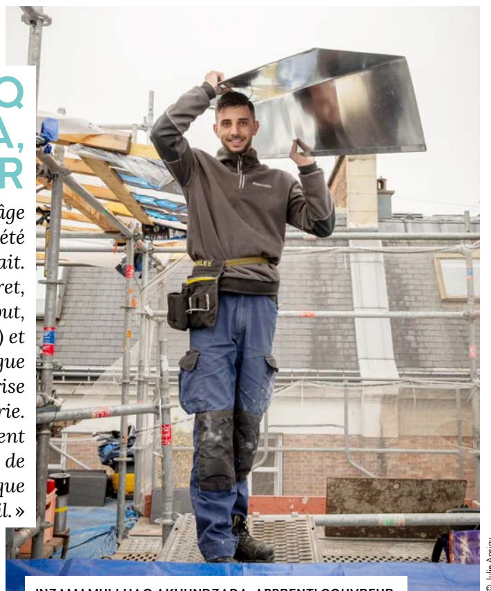
INZAMAMULLHAQ AKHUNDZADA, APPRENTI COUVREUR.
