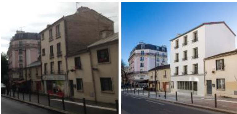
Before/after 87 rue Buzenval Crédits photo ©Serge Detalle
