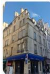
23-25 rue des deux ponts, 75004 Paris
