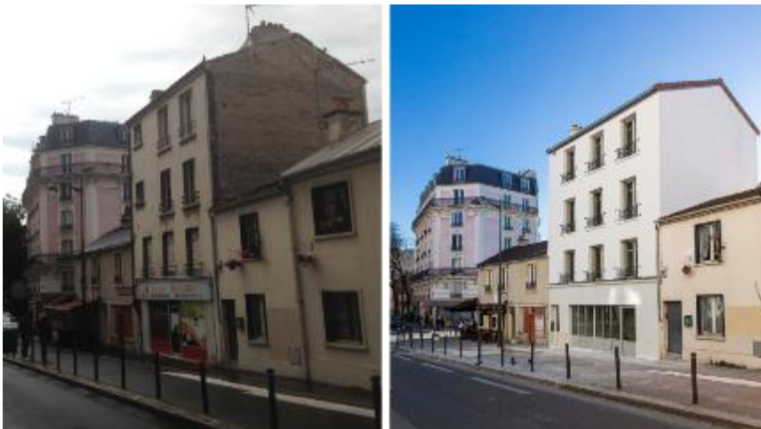
Avant / après du 87 rue Buzenval - Crédits photo ©Serge Detalle
