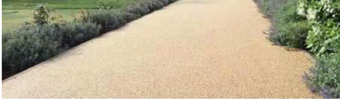
Béton micro désactivé sur allée pentée: promenade piétonne rue Lartet
