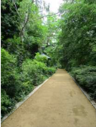
Stabilisé sur allée plane: promenade piétonne rue Archinard
