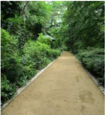
Bordure en béton clair
