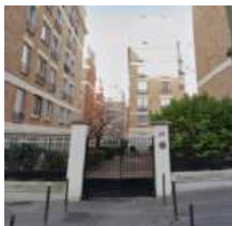
failles et grilles séparatives
