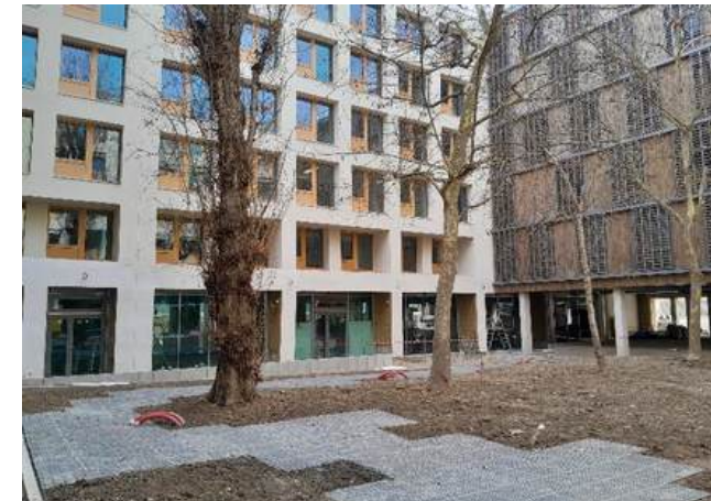
Bâtiment B, façade Nord
