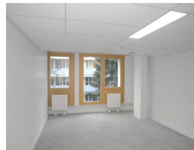
Bâtiment B, bureaux
