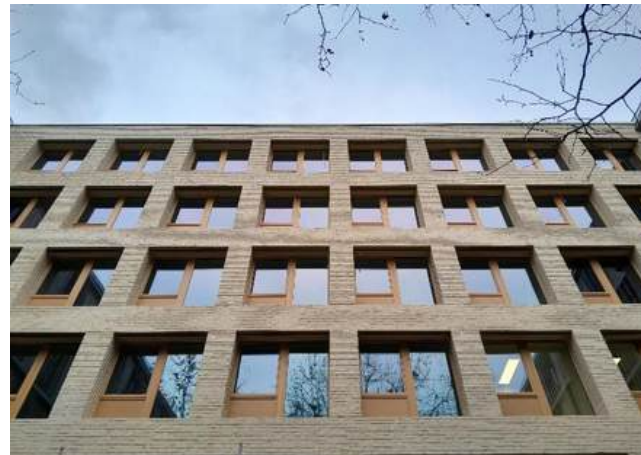
Bâtiment A, façade sud
