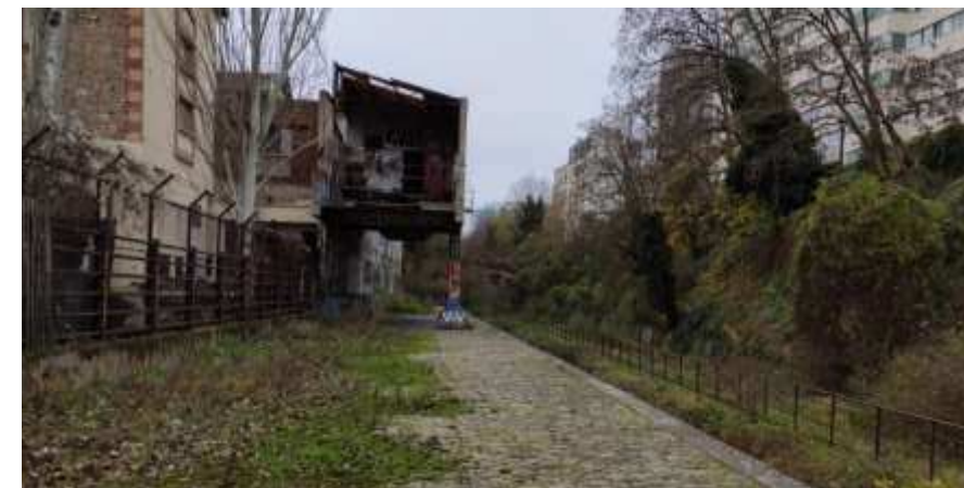
3 Ancien bâtiment délabré
