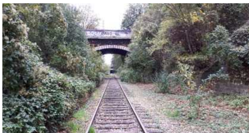
5 Sous le pont de la rue Brancion
