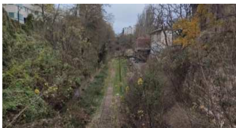
3 PC vue depuis le pont rue Brancion
