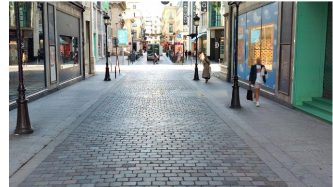
Rue Caumartin, 9 e Profil de chaussée en W avec des caniveaux en V
