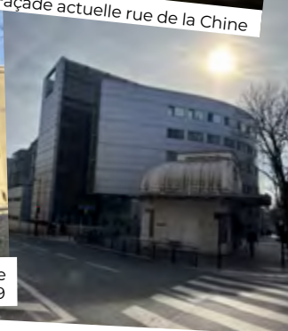
Extension de 2013, au niveau du métro Pelleport
