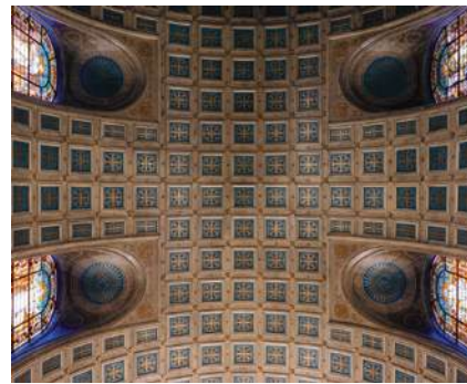
Les caissons nettoyés de l'église Saint-Philippe du Roule
