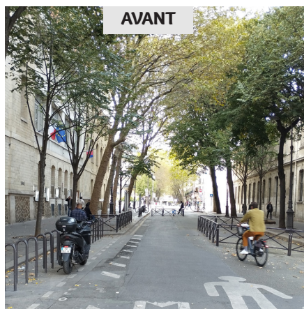
rue Louis Blanc - avant travaux, septembre 2023
