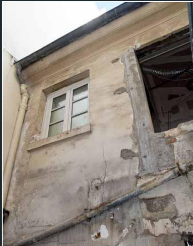
Vue des façades sur la cour intérieure avec renforcement en béton des murs, 2025 (© DHAAP / ML).
