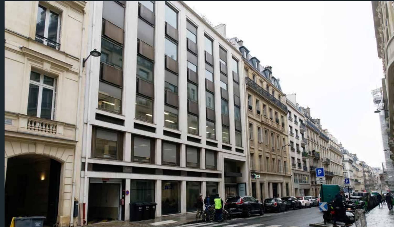
le maître d'œuvre, le projet a été revu. Le complexe en laine de roche de 16 cm d'épaisseur a été remplacé par un enduit correcteur thermique d'environ 6 à 8 cm d'épaisseur pour les façades sur rue, ce qui correspond à la profondeur de la purge des anciens enduits. Cela tend à répondre à la résolution de la CVP, qui s'inquiétait de la surépaisseur du dispositif initialement envisagé, bien que les couleurs de ces revêtements aient alors été maintenues.
