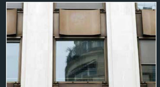
Allège avec table métallique dissimulant les anciennes sorties de ventilation, 2025 (© DHAAP / ML).
