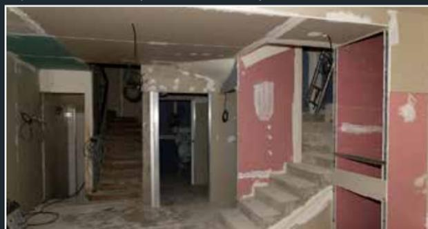
Vue du rez-de-chaussée du n°5 rue Gomboust, construction du nouvel escalier vers le R+1 et du monte-charge, 2025 (© DHAAP / ML).
