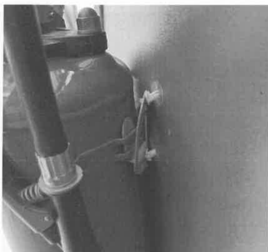
Figure 22 : extincteur mal arrimé salle à manger RDC
