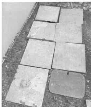
Figure 2 : dalles mouvantes de l'entrée de la résidence
