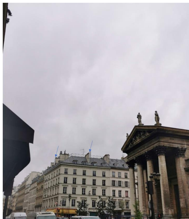
Après travaux : Prise de vue 1
