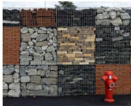
Centre de tri et recyclage, mur en gabions de réemploi
