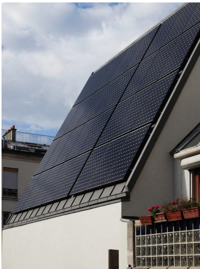
Cas n°1: Dans le cas de toitures en pente, les panneaux seront préférentiellement intégrés à la pente dans l'épaisseur de la couverture. Dans ce cas, il faut s'assurer que l'orientation de la pente permet un rendement annuel suffisant de l'installation solaire.
