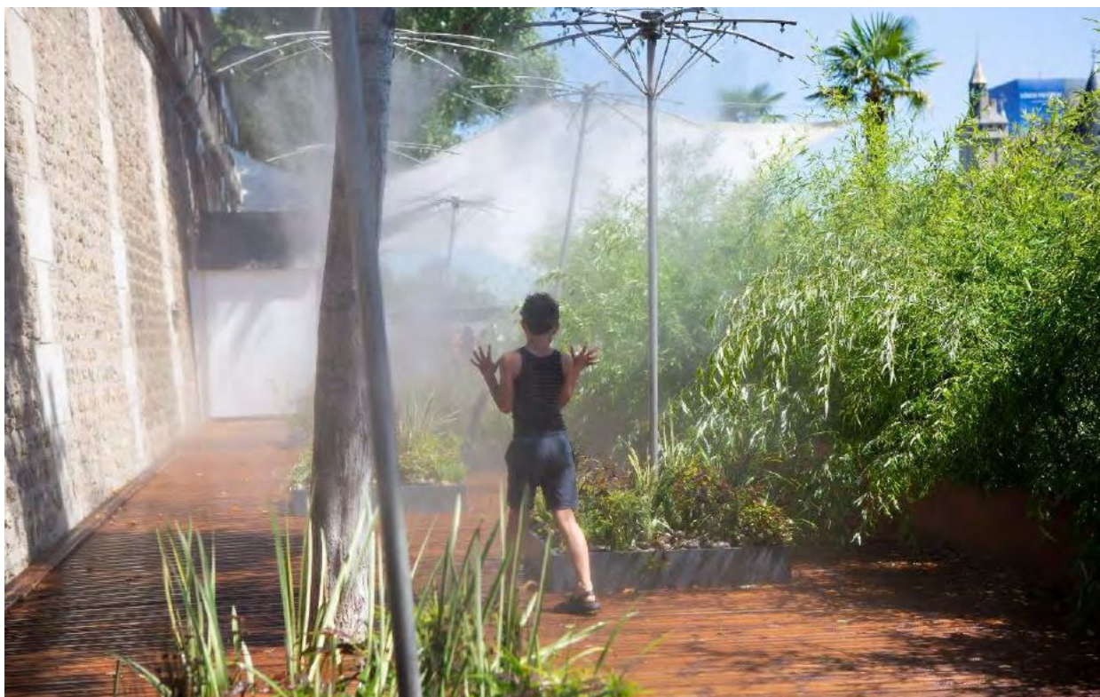
Brumisateur installé dans le cadre du programme annuel Paris Plage
