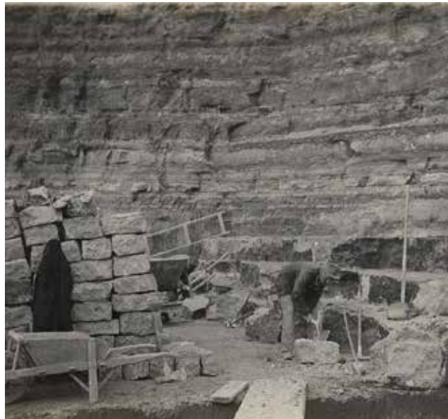
Exploitation du Calcaire Grossier à ciel ouvert au début du XXe siècle
