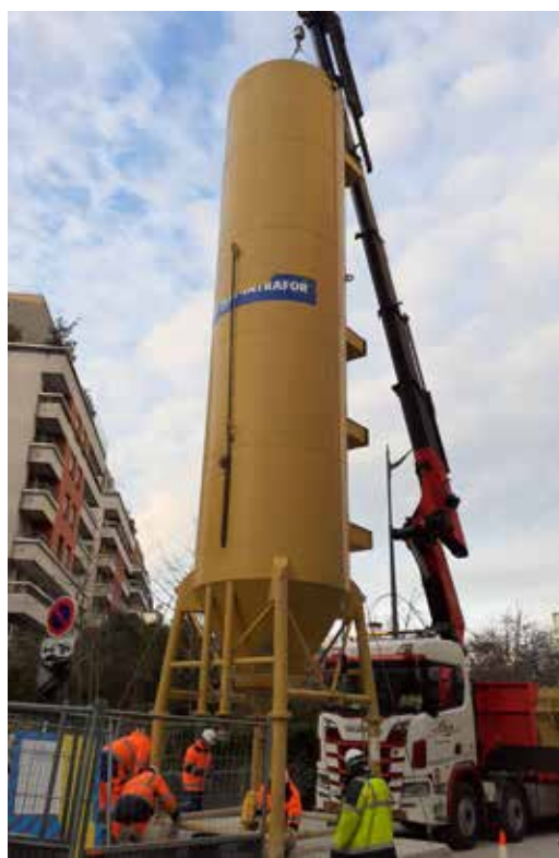
Chantier de consolidation des sols - Paris 15 e À gauche, l'aspiratrice en place et son bac de vidange, À droite, l'installation d'un silo de ciment
