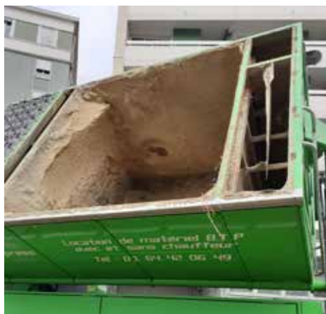
Chantier de consolidation des sols - Paris 15 e À gauche, l'aspiratrice en place et son bac de vidange, À droite, l'installation d'un silo de ciment
