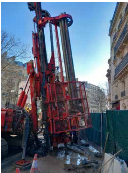
Chantier d'injections solides À gauche, la foreuse, À droite, le trottoir déformé
