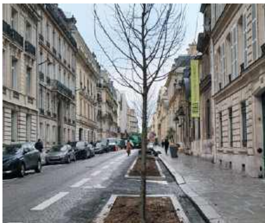
Végétalisation de la rue Monceau: Deuxième phase Travaux concessionnaire CPCU
