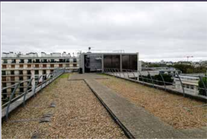
Vue du toit avec édifice technique, 2024 (© DHAAP / ML).
