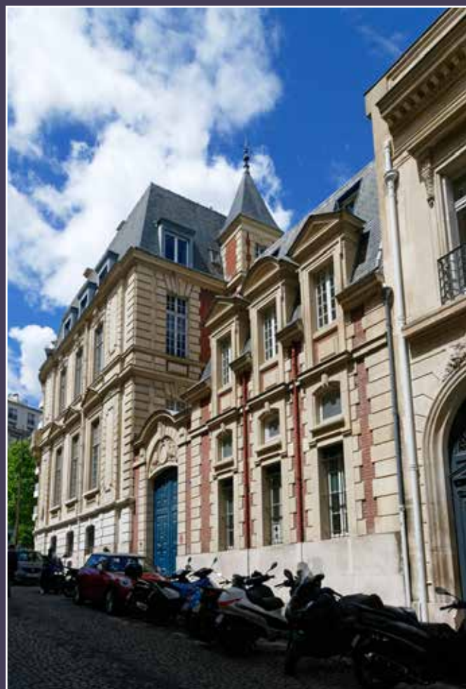
Vue de la façade sur rue Georges Bizet, ancien bâtiment des écuries, 2022 (© DHAAP / ML).
