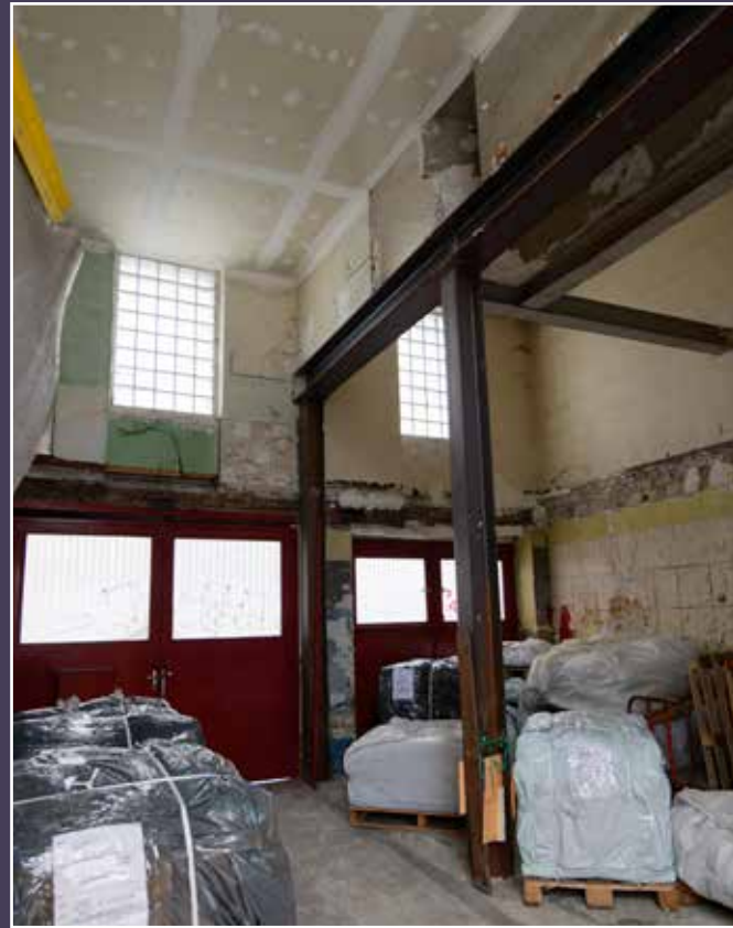
Vue intérieure des bâtiments de la rue Philippe de Girard. Seules les façades sont encore en place, 2024 (© DHAAP / PS).
