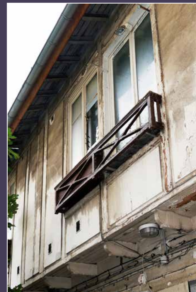
Détail de l'encorbellement de l'aile et de son système constructif, 2024 (© DHAAP / ML).
