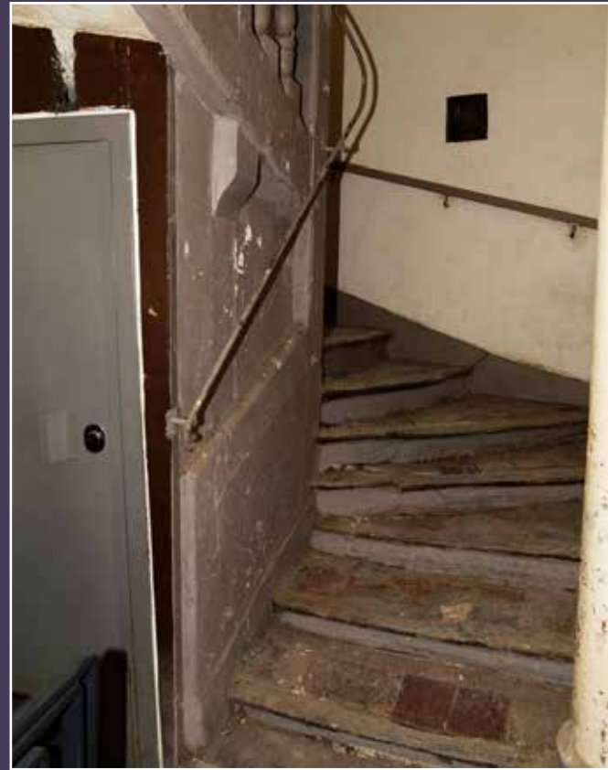
Vue de l'escalier du n° 11, 2023, (© DHAAP / ML).
