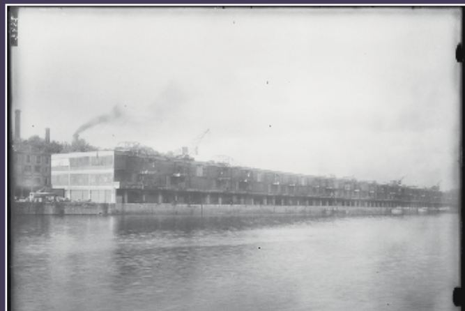
Vue des entrepôts depuis la Seine (© DHAAP).
