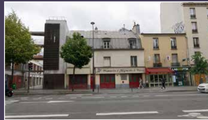
Vue sur la rue Marx Dormoy. À gauche, la parcelle démolie en 2005, 2024 (© DHAAP / PS).
