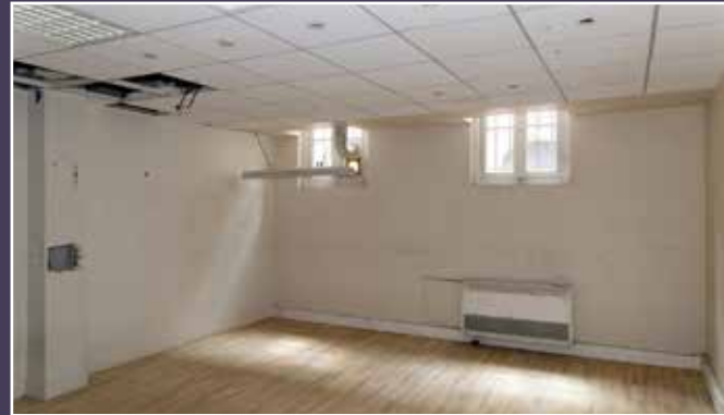
Vue du rez-de-chaussée (Bâtiment B), réhabilitation des années 2000, 2022 (© DHAAP / ML).
