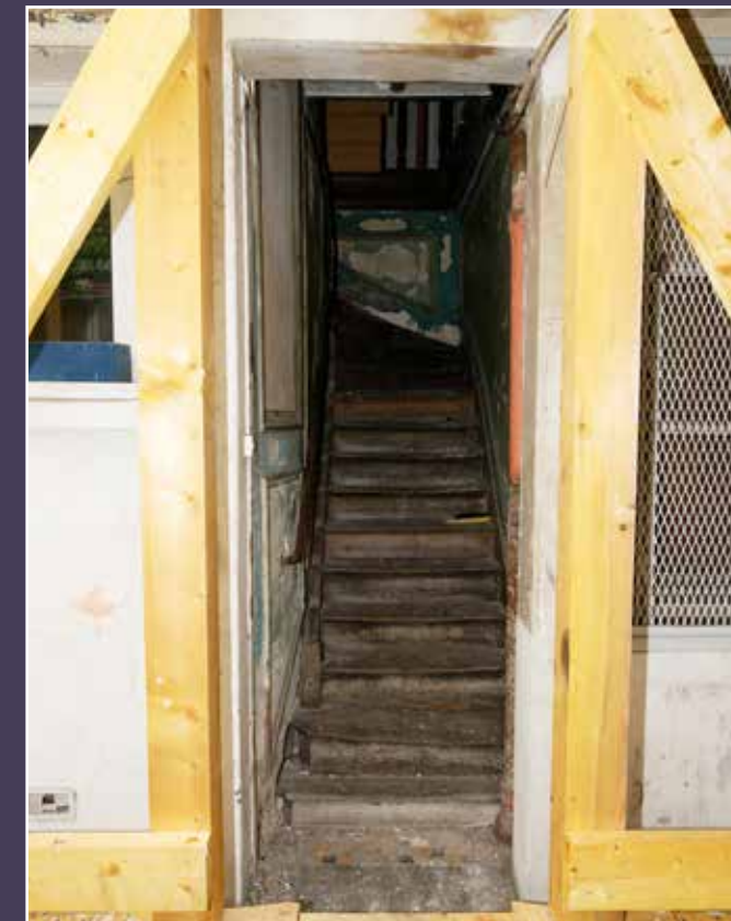
Vue du départ de l'escalier, 2024 (© DHAAP / ML).
