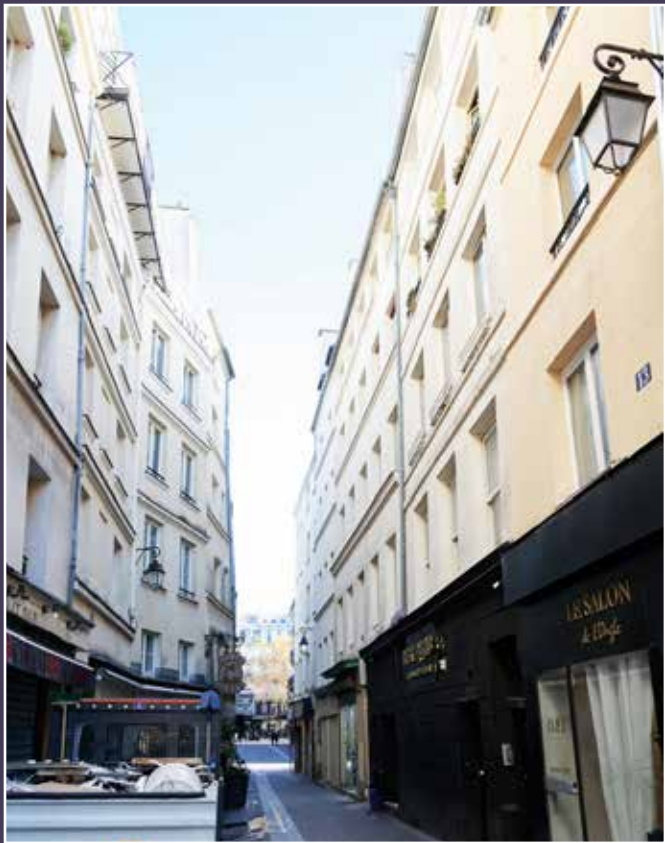
Vue des façades depuis la rue, 2023 (© DHAAP / ML).
