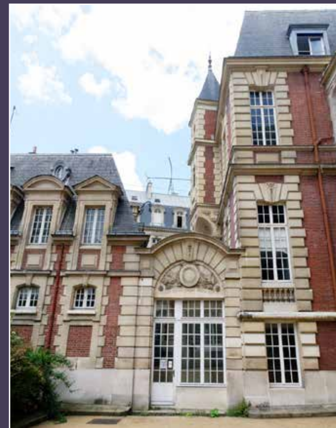
Vue de la façade sur cour, côté rue George Bizet, 2022 (© DHAAP / ML).
