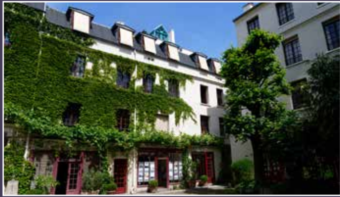
Vue du bâtiment où se situe l'escalier, 2022 (© DHAAP / ML).
