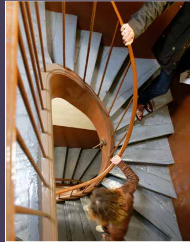
Vue de l'escalier à limon dans l'aile à gauche dans la cour, 2024 (© DHAAP / PS).
