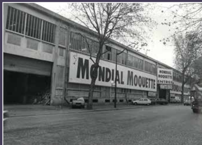
Photographie avant démolition des pavillons, 1990 (© DHAAP).
