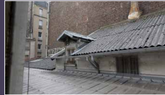
Vue de l'aile à droite dans la cour et sa lucarne avec poulie, 2024 (© DHAAP / PS).
