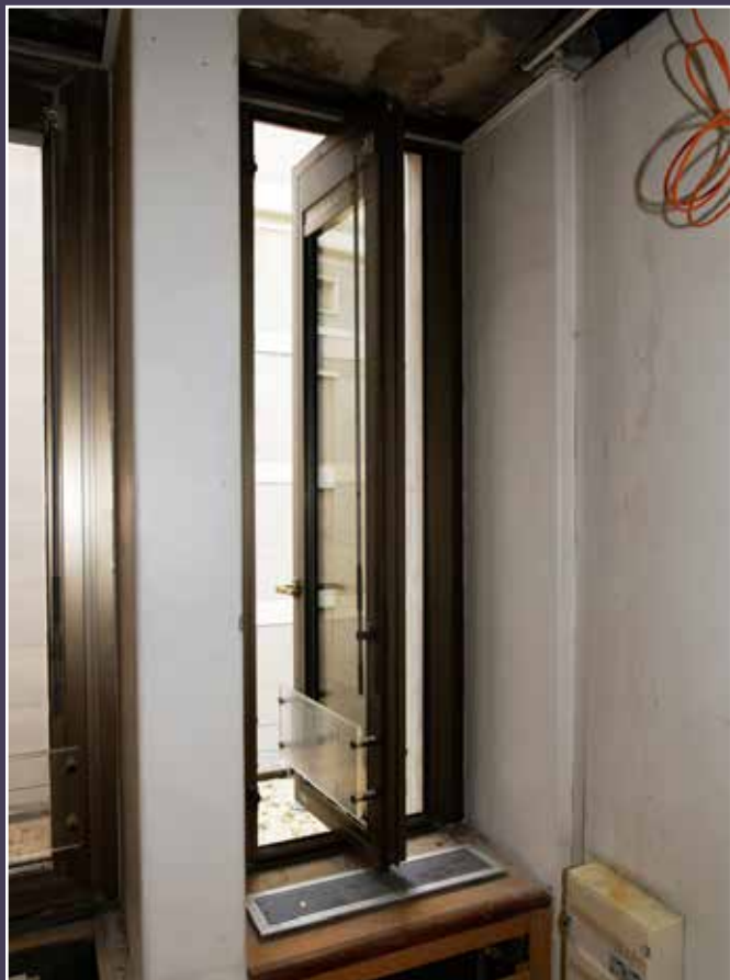
Détail d'une menuiserie, avec ajout d'un garde-corps vitré, 2024 (© DHAAP / ML).
