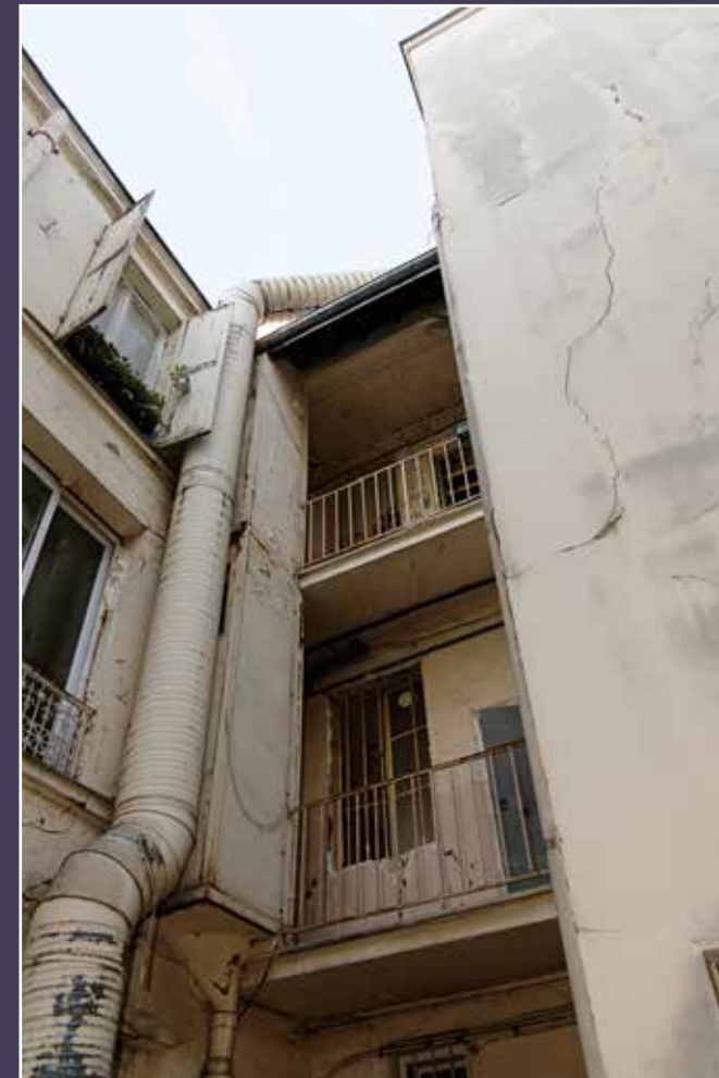
Cour du n° 9, vue des coursives, 2023 (© DHAAP / ML).
