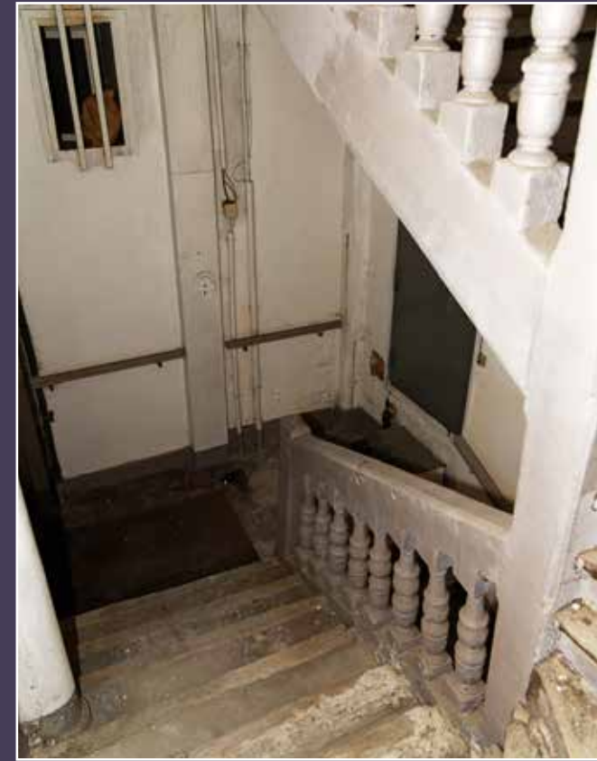
Vue de l'escalier du n° 11, 2023 (© DHAAP / ML).
