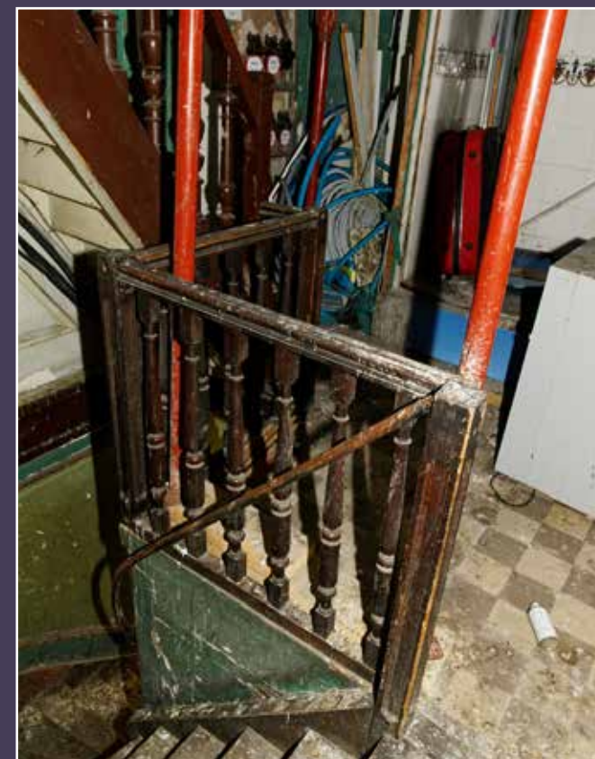
Vue de la cage d'escalier étayée, 2024 (© DHAAP / ML).
