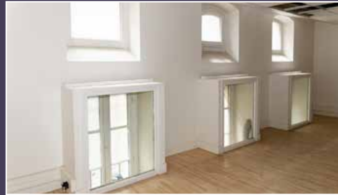
Vue de l'entresol (Bâtiment B), réhabilitation des années 2000, 2022 (© DHAAP / ML).
