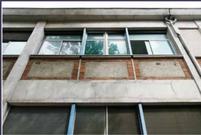
Détail des façades aux allèges ornées de brique, les menuiseries ont été remplacées, 2024 (© DHAAP / ML).
