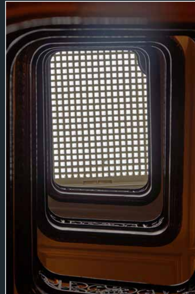
Vue de la voûte en pavés de verre, cage d'escaliers du 155 boulevard Haussmann, 2024 (© DHAAP / PS).
