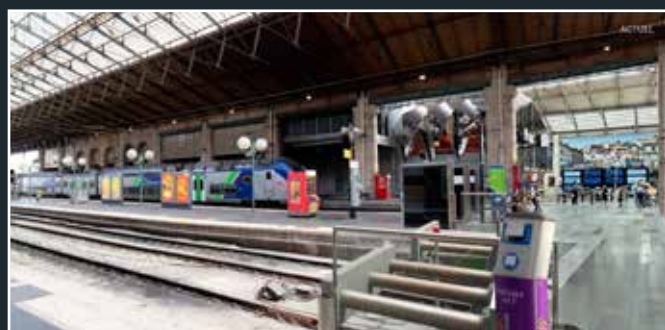
Vue de l'existant dans l'aile est (© AREP).
