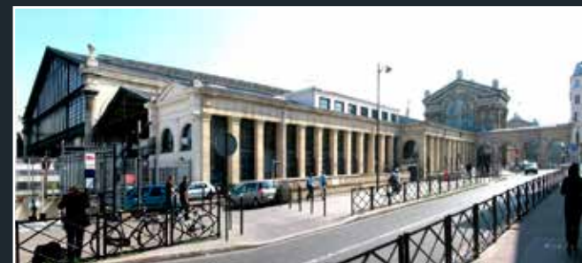
Vue actuelle de l'aile ouest au droit de l'extension envisagée. À l'arrière-plan, à droite de l'image, les arcades enjambant la voie de desserte située entre la gare et l'ancien siège de la Compagnie de chemins de fer du Nord (© AREP).
