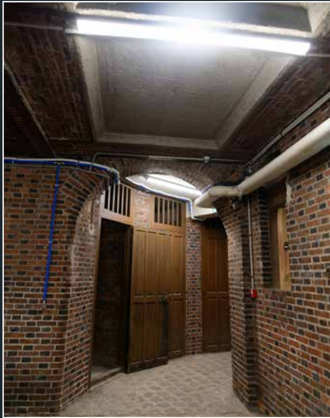
Vue des écuries 2, 151-155 boulevard Haussmann, 2024 (© DHAAP / PS).
