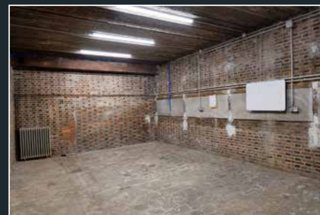
Vue des écuries 3, 151-155 boulevard Haussmann, 2024 (© DHAAP / PS).
