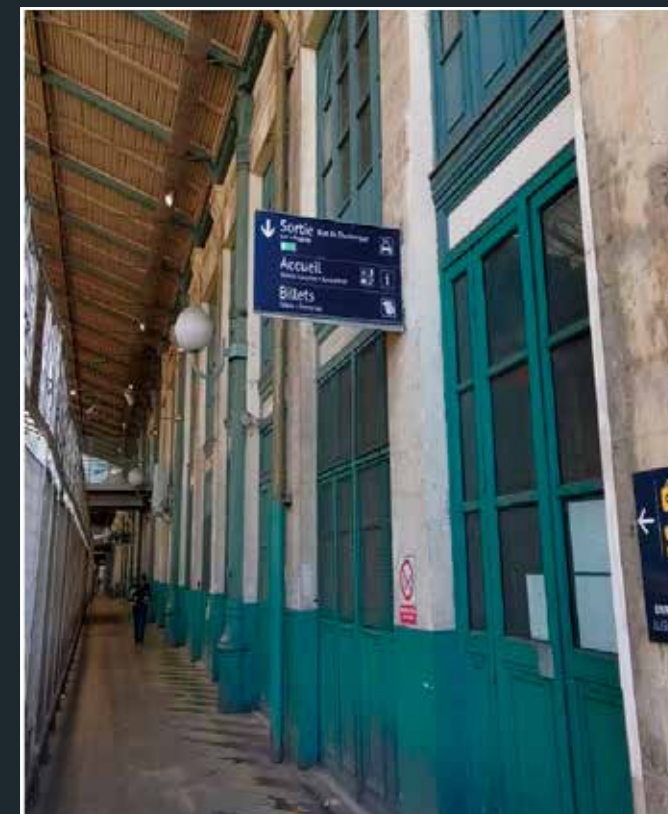
Vue actuelle de la façade intérieure de l'aile ouest dans sa partie nord. Au premier plan, les poteaux en fonte et le remplissage en briques enduites (© AREP).
