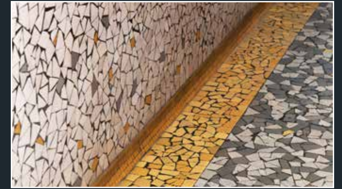
Exemple de décors à carreaux cassés dans les couloirs promis à la dépose, 2024 (© DHAAP / ML).
