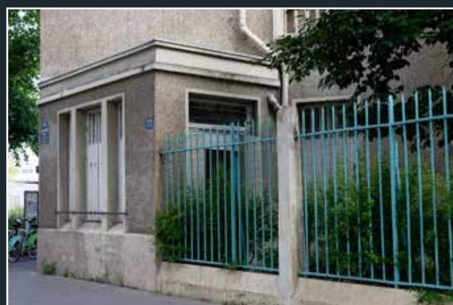
Vue de l'édicule promis à la démolition, 2025 (© DHAAP / PS).
