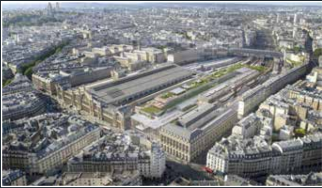
Vue aérienne perspective du projet ayant fait l'objet d'un permis de construire en 2019 (© Valode et Pistre architectes).
