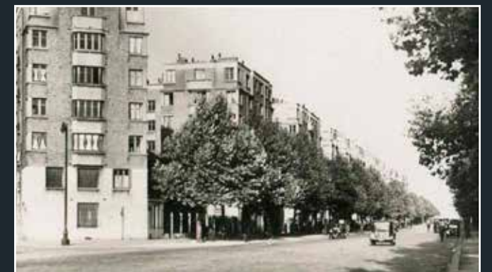
Vue de la proue de l'HBM (actuel bâtiment G1), depuis le boulevard Ney, s.d. (© Archives de Paris Habitat).
