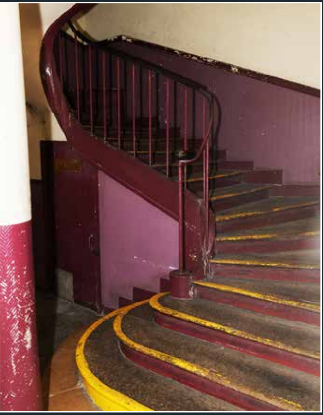
Vue des escaliers, 20 rue de la Sourdère, 2025 (© DHAAP / ML).
