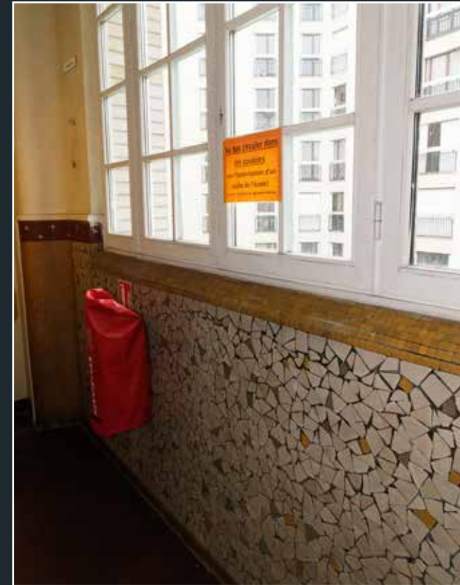
Exemple de décors à carreaux cassés dans les couloirs promis à la dépose, 2024 (© DHAAP / ML).
