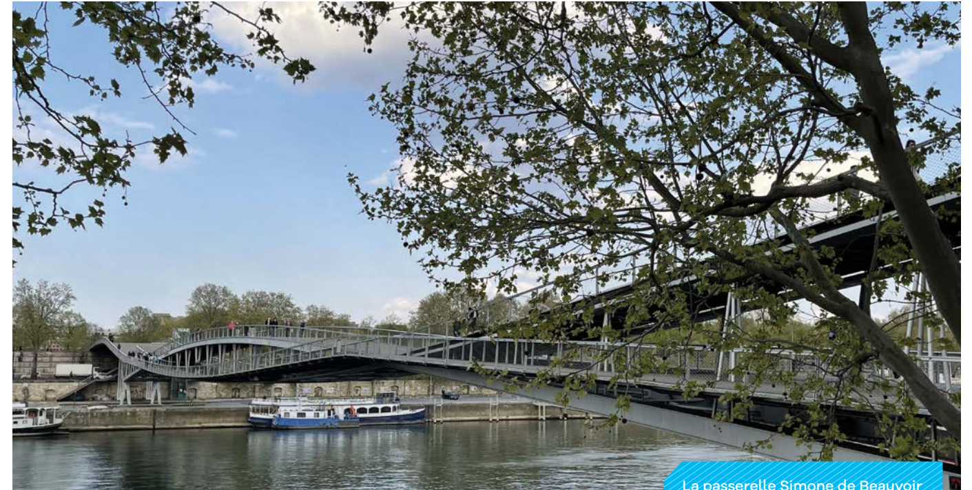
La passerelle Simone de Beauvoir
