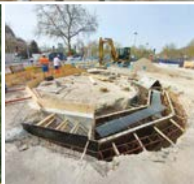
Les travaux de terrassement du bassin de rétention
