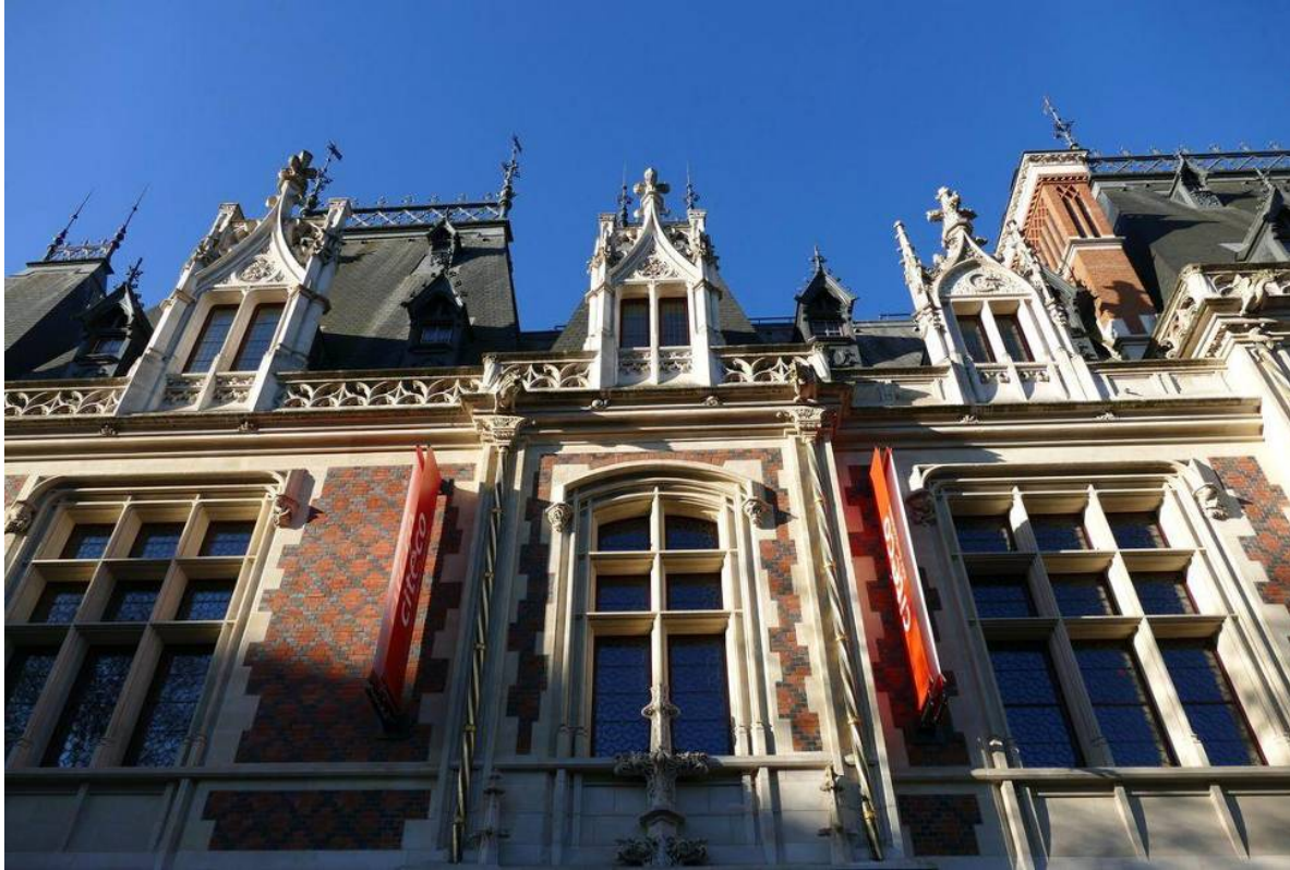
Modénatures de la façade principale © CAUE de Paris
