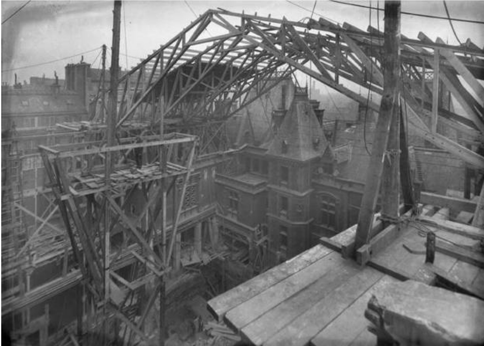
Le chantier du futur hall Drefasse et son sous-sol © Licence Creative Commons
