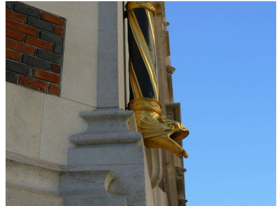
Détail de dauphin sur la descente d'eaux pluviales © CAUE de Paris
