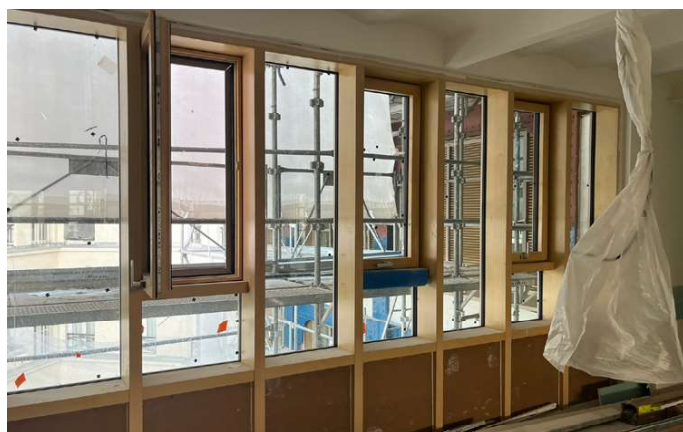
La façade rideau en menuiseries bois-alu © CAUE de Paris
