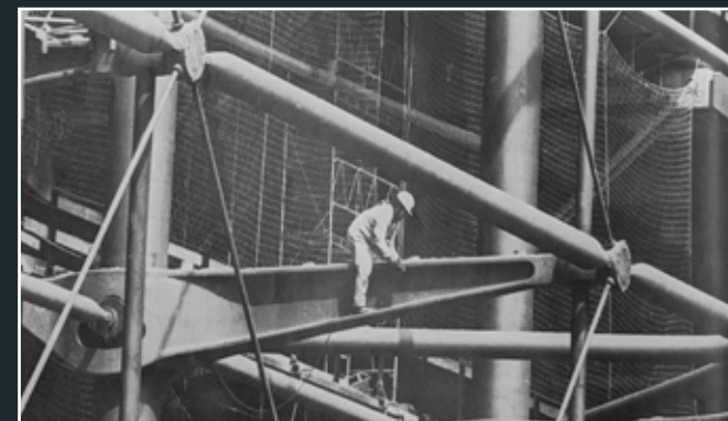
Vues des gerberettes en cours de montage, 1977 (vers), AA, n° 183, février 1977.
