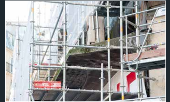
Vue de l'auvent à pavés de verre certainement placé en 1958, décembre 2025 (© DHAAP / JP).
