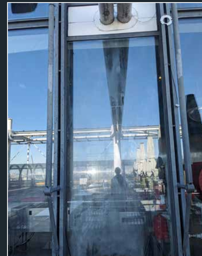
Altération du verre observée sur certains panneaux lors de la visite du site, mai 2025 (© DHAAP / Houssard).
