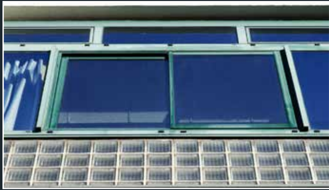
Détail des baies et des allèges en briques de verre, 2025 (© DHAAP / ML).
