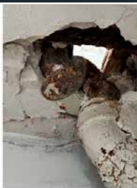
Dégradations au droit d'une chute
