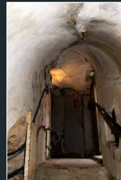
Fissures au niveau de la voûte de l'escalier, 2025 (© DHAAP / ML).
