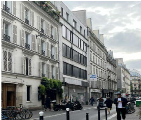
Photo de la façade existante
