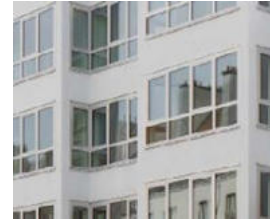
Enduit à la chaux
