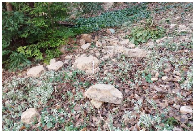
Chute de pierres au droit des falaises du Front de Taille
