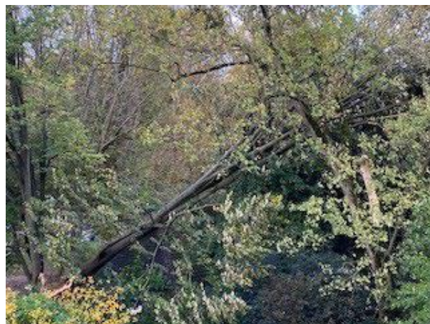
Chute d'arbres au droit des falaises
