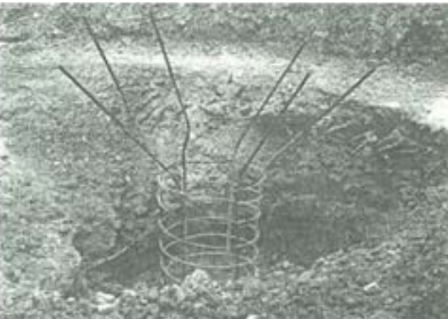
Etablissement de puits, réfection du radier ©DPJEV, circonscription Nord-Est, 1956
