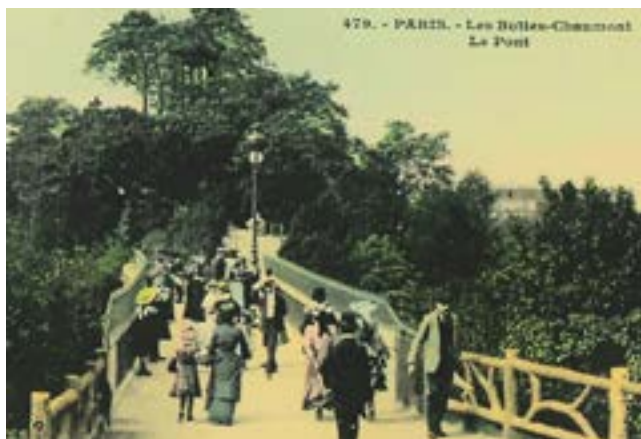
Vue du pont voûté du parc des Buttes-Chaumont, traversé par les promeneurs et promeneuses ©Carte postale ancienne, vers 1904
