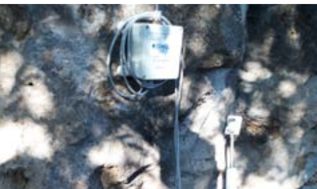
Instrumentation sur les fissures existantes sur l'île ©DEVE, 2024
