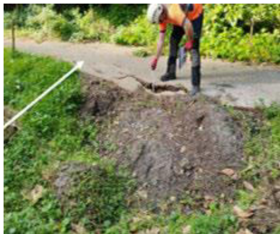
Glissement de terrain devant la grotte
