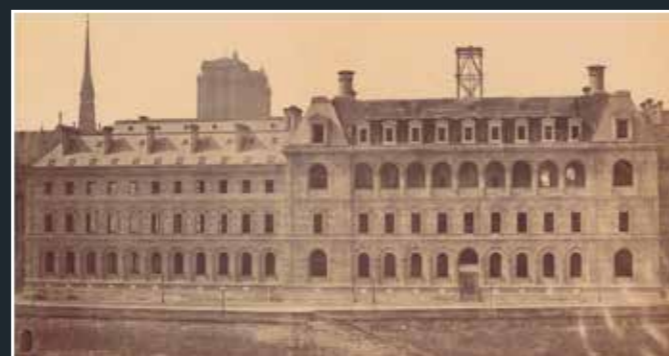
Anonyme, L'Hôtel-Dieu en chantier (© BHVP / Roger-Viollet).
