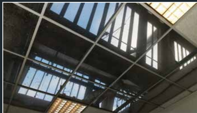
Bureau de poste du site de La Rochefoucauld, vue des verrières des sheds, 2026 (© DHAAP / ML).
