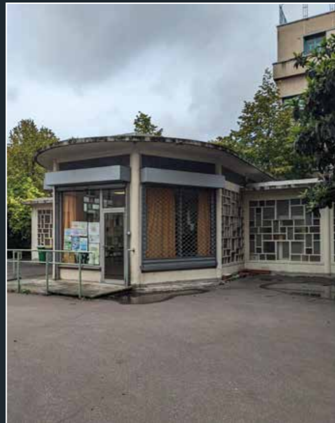
Vue du préau modifié avec parois vitrées semblables à celles de la PMI de 1962, 2023 (© DHAAP / ML).
