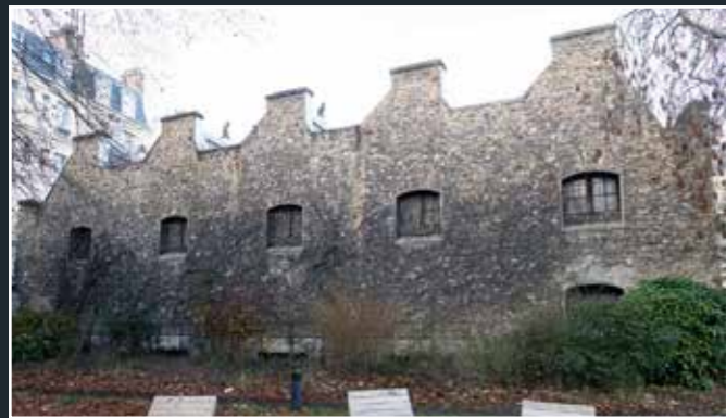
Bureau de poste du site de La Rochefoucauld, façade est avec cour anglaise, 2026 (© DHAAP / ML).
