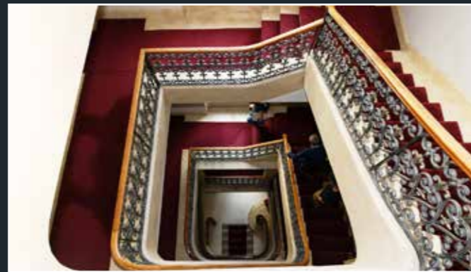
Vue du vide central de l'escalier dont la démolition est demandée, 2025 (© DHAAP / ML).
