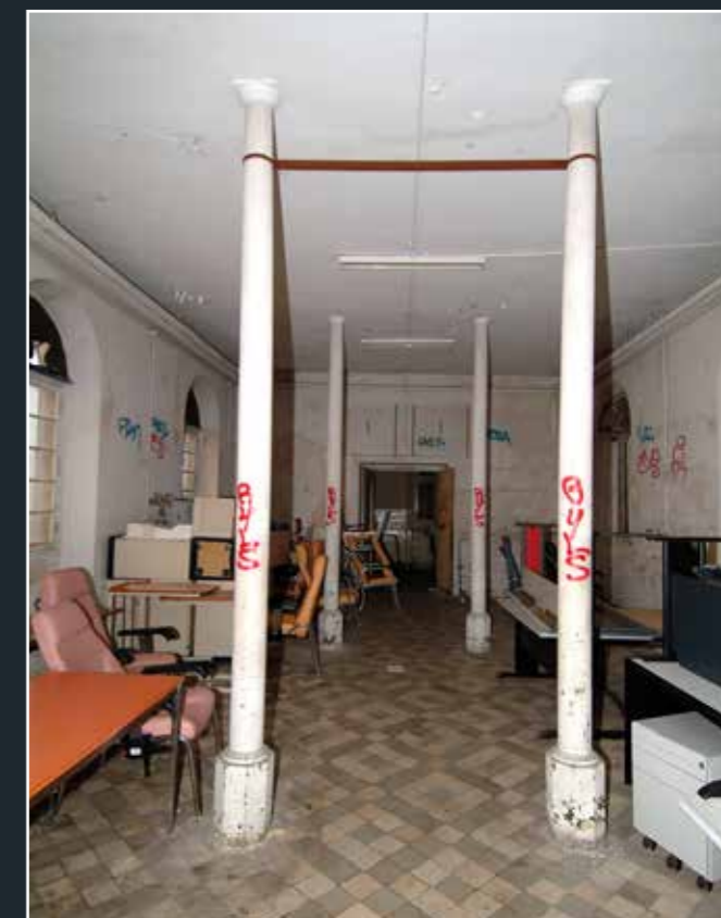
Hôpital La Rochefoucauld, vue intérieure des anciennes infirmeries, 2006 (© DHAAP / ML).
