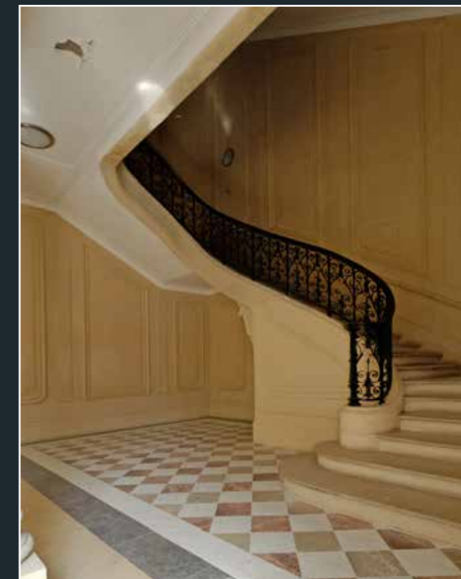
Vue de l'escalier d'honneur, 2011 (© DHAAP / Christian Rapa).
