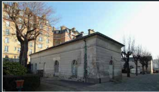
Hôpital La Rochefoucauld, vue des anciennes infirmeries, 2006 (© DHAAP / ML).
