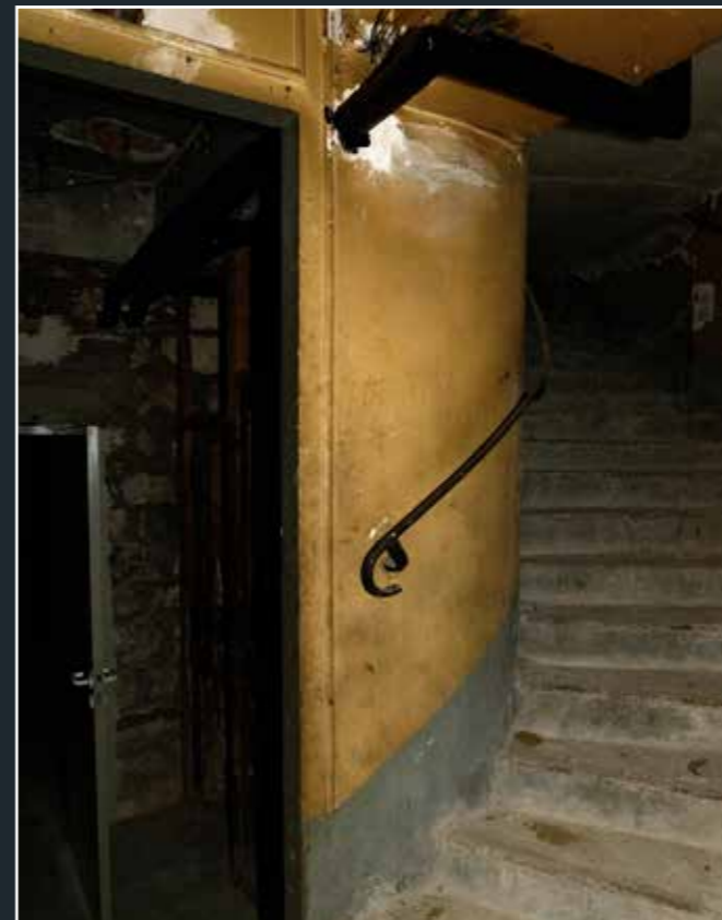
Bureau de poste du site de La Rochefoucauld, vue de l'escalier du sous-sol, 2026 (© DHAAP / ML).
