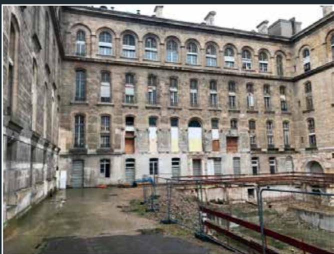
Hôtel-Dieu, vue de l'une des cours après la destruction des édifices construits au XX e siècle (© Barthélémy Grîno, Valero Gadan, Goutal & Clément).
