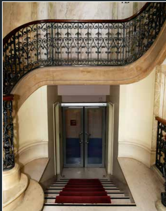
Vue du départ de l'escalier dont la démolition est demandée, 2025 (© DHAAP / ML).
