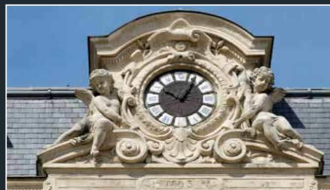
Détail de la façade du bâtiment principal du 8 rue de Londres, l'horloge, 2011 (© DHAAP / Christian Rapa).
