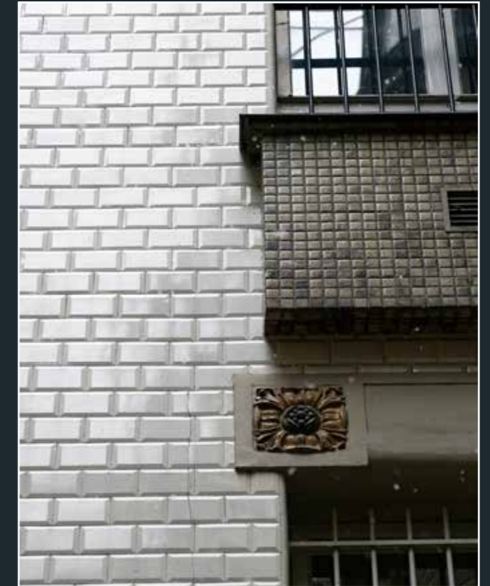
Détail des matériaux sur cour, 2026 (© DHAAP / ML).
