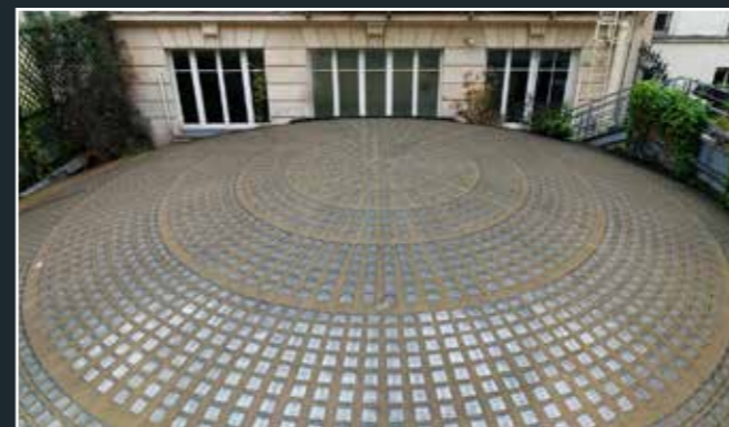
Vue de la coupole construite dans la cour depuis l'extérieur, 2024 (© DHAAP / ML).
