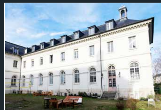
Hôpital La Rochefoucauld, bâtiment principal côté avenue René Coty, aile gauche, 2026 (© DHAAP / ML).
