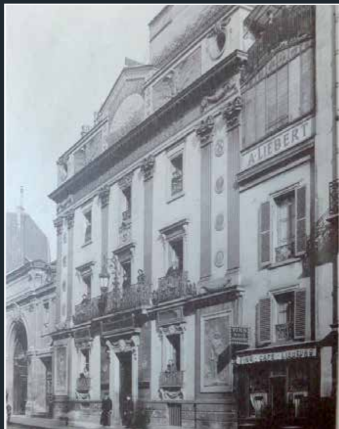
Façade du 6 rue de Londres, [vers 1880-1900] (BnF).
