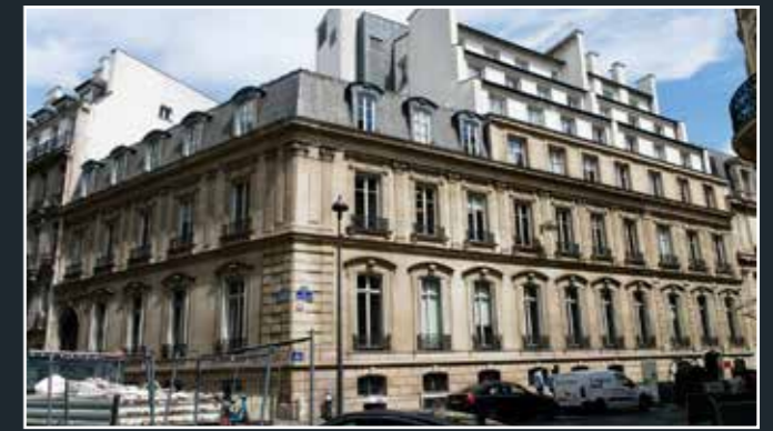
Vue de l'ensemble à l'angle de la rue de Ponthieu (à gauche) et de la rue Paul Baudry (à droite), 2025 (© DHAAP / ML).
