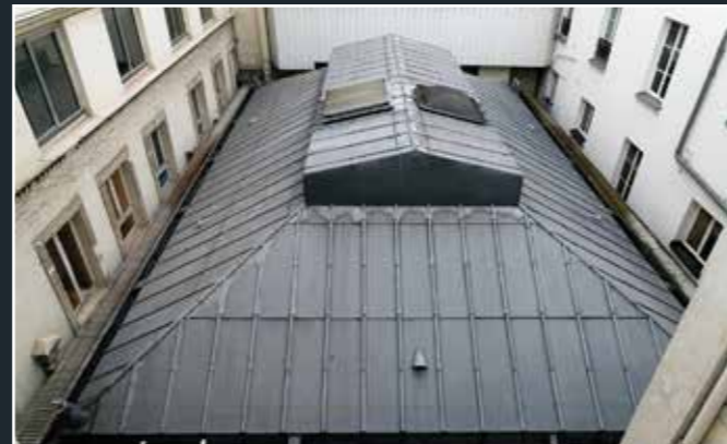
Vue de la verrière couverte en zinc (© Tolila + Gilliland Atelier d'architecture).
