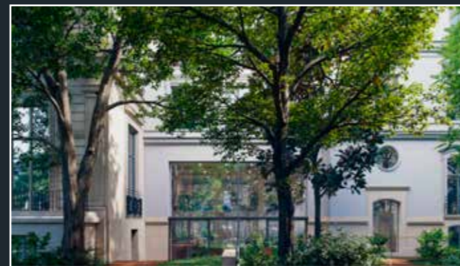
Vue du revers, côté cour, du hall d'entrée.
