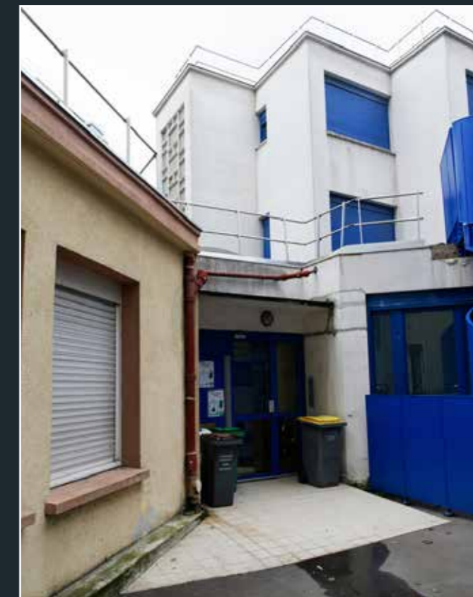
Vue de la façade arrière de la crèche, en partie proche de son état d'origine, connectée à La Pomme , 2023 (© DHAAP / ML).
