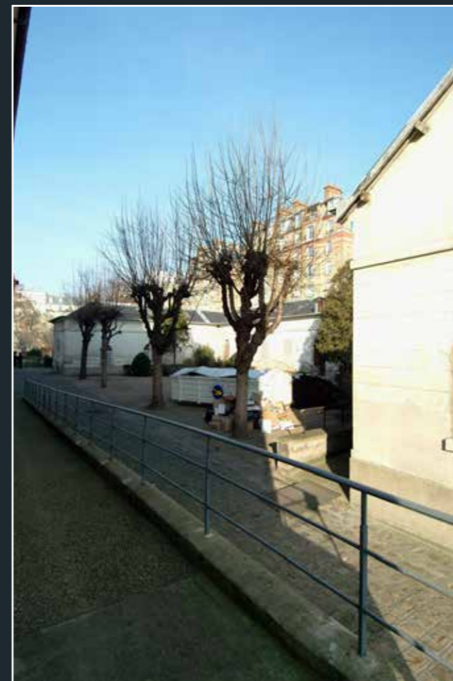
Hôpital La Rochefoucauld, vue des anciennes infirmeries, 2006 (© DHAAP / ML).
