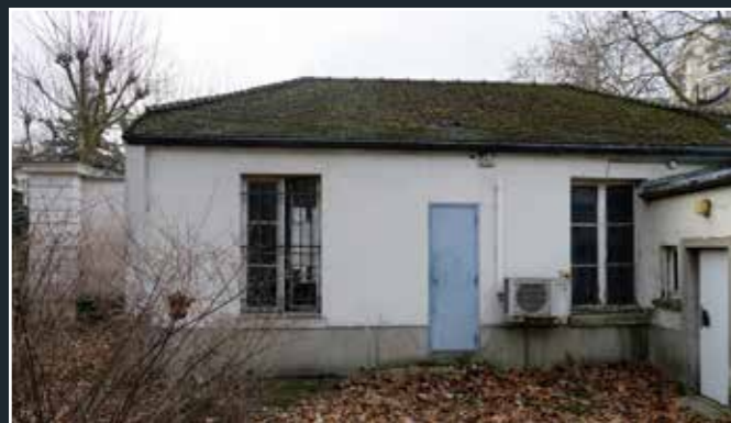
Hôpital La Rochefoucauld, pavillon dit de la loge, façade secondaire, 2026 (© DHAAP / ML).
