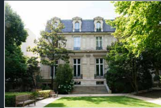
Vue de l'hôtel particulier du 3 rue Paul Baudry, façade sur jardin, 2025 (© DHAAP / ML).
