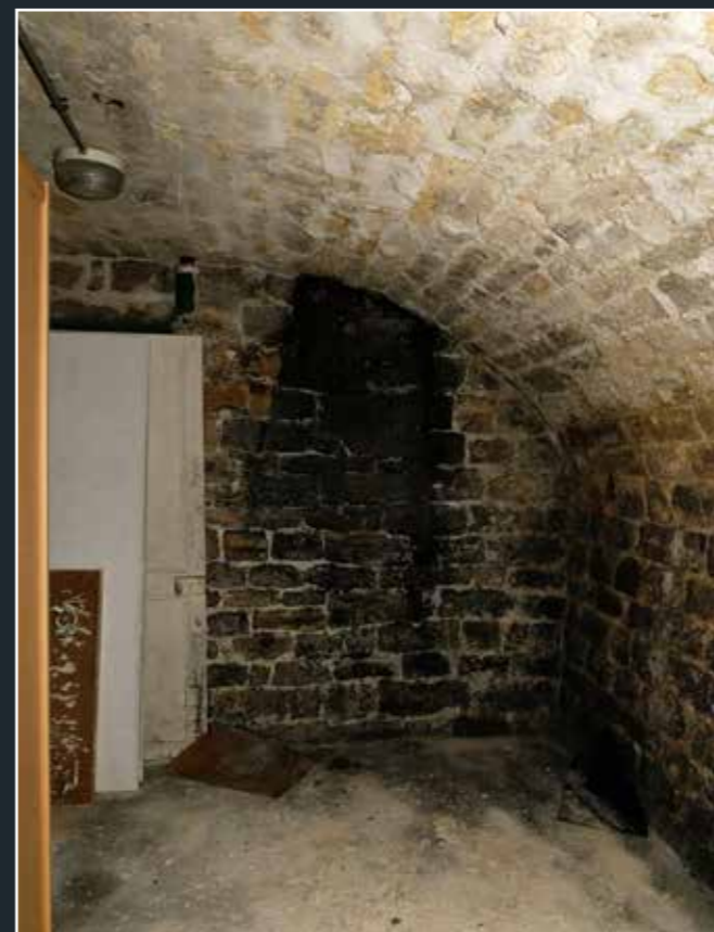
Hôpital La Rochefoucauld, pavillon d'entrée principal, caves, 2026 (© DHAAP / ML).
