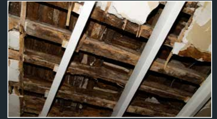
Vue d'un plancher du 28 rue d'Astorg, 2024 (© DHAAP / ML).
