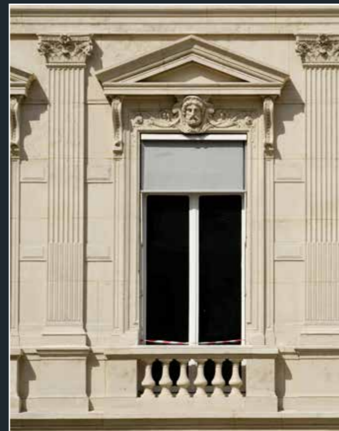
Détail de la façade du bâtiment principal du 8 rue de Londres, modénature, 2011 (© DHAAP / Christian Rapa).
