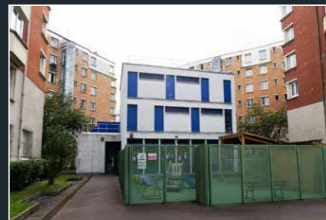
Vue de la façade principale de la PMI devenue crèche, 2023 (© DHAAP / ML).
