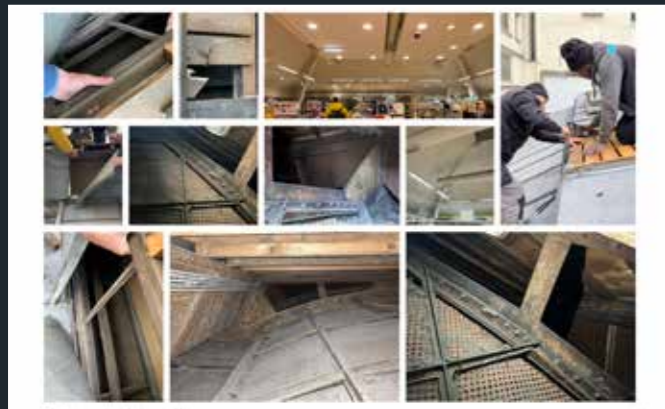
Sondage de reconnaissance de la structure de la verrière (© Tolila + Gilliland Atelier d'architecture).
