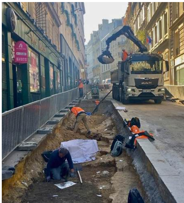
Fouille d'une jardinière en cours d'aménagement rue Cujas. © DHAAP
