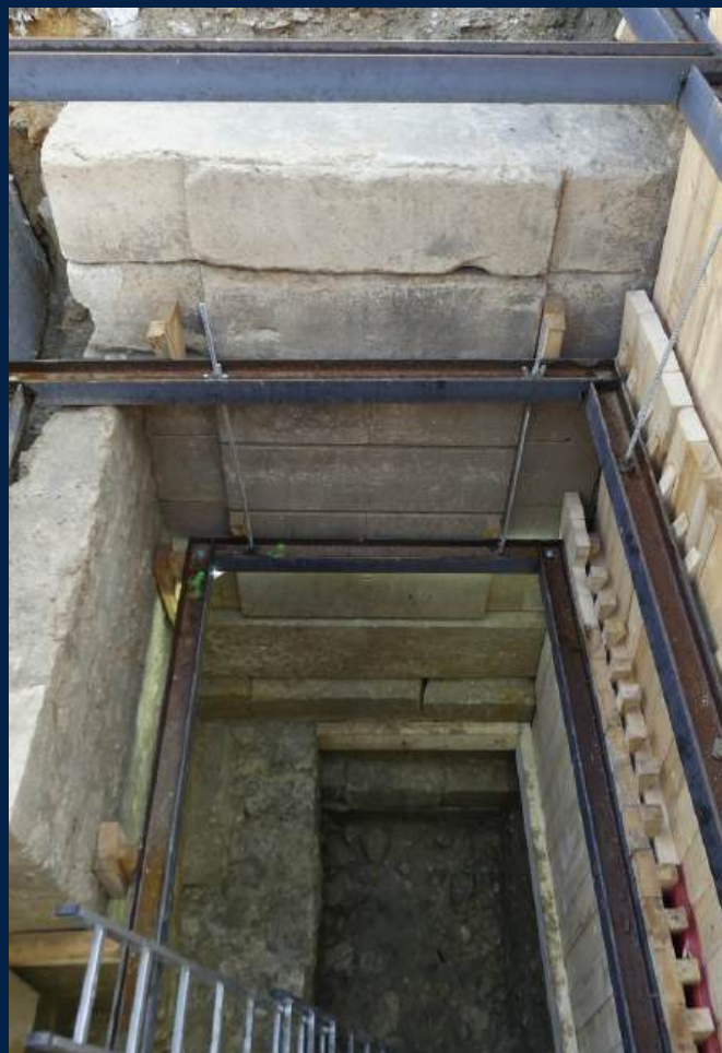
Vestiges d'une maçonnerie bordant les anciens fossés de la Concorde au XVIII e siècle. © T. Fignon/ DHAAP
