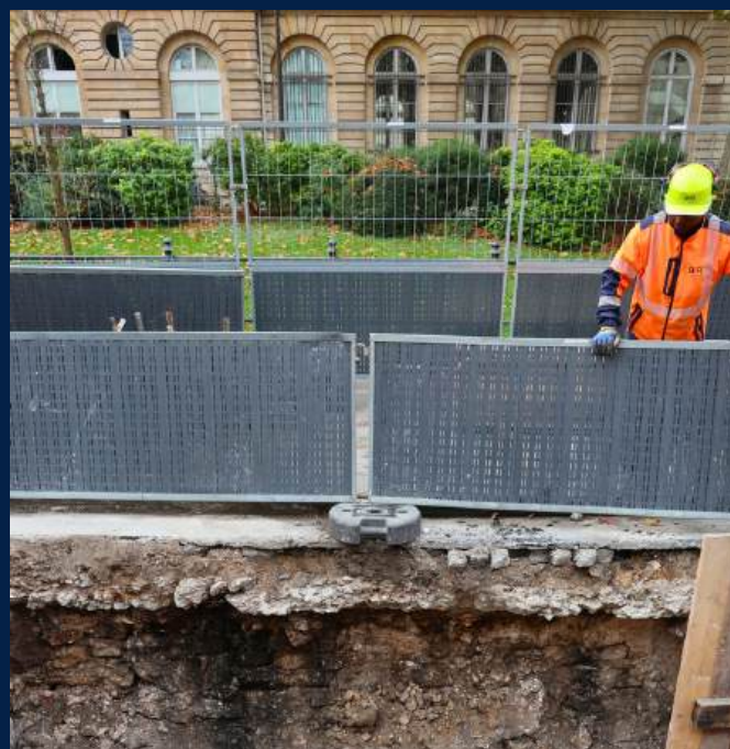
Aménagement d'un réseau de fraîcheur à proximité du Collège de France. © J.-F. Goret/ DHAAP
