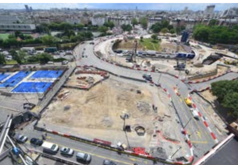
Les travaux ont démarré porte de Montreuil
